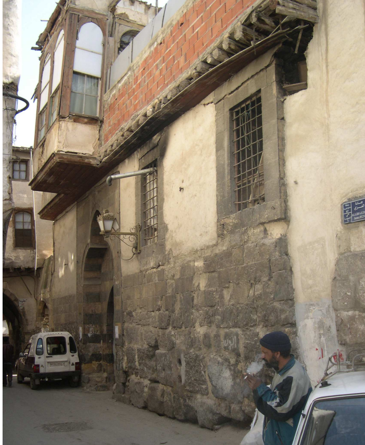
Figure 1. Damas. Mur de la période antique qui constitue le soubassement d'une mosquée de la période mamelouke, lui-même surélevé au cours de la période ottomane par un oriel construit en bois et en terre. Le garde-corps qui couronne la mosquée est en brique et surmonté de panneaux de tôles. Photo de l'auteur, fév. 2004.
