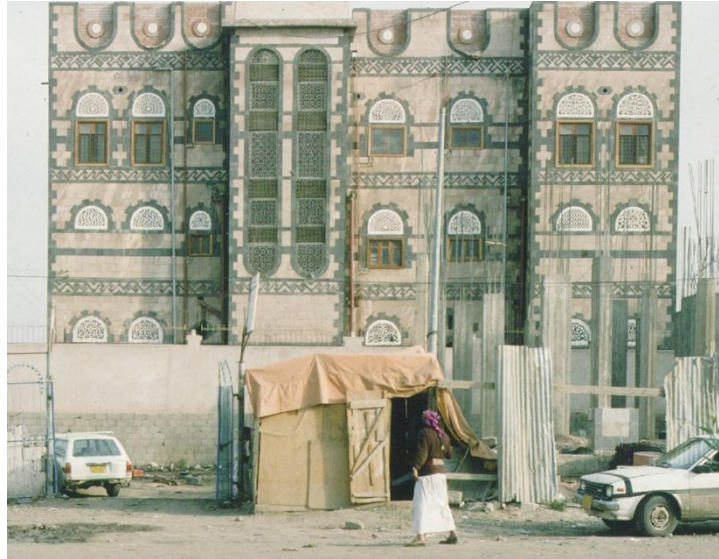
Figure 6. Verticalité de la cage d'escalier Photo de l'auteur, 1990
