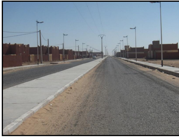
Photo n°2. Nouvelles extensions de la ville d'Adrar (logements LSP à Tililane)
