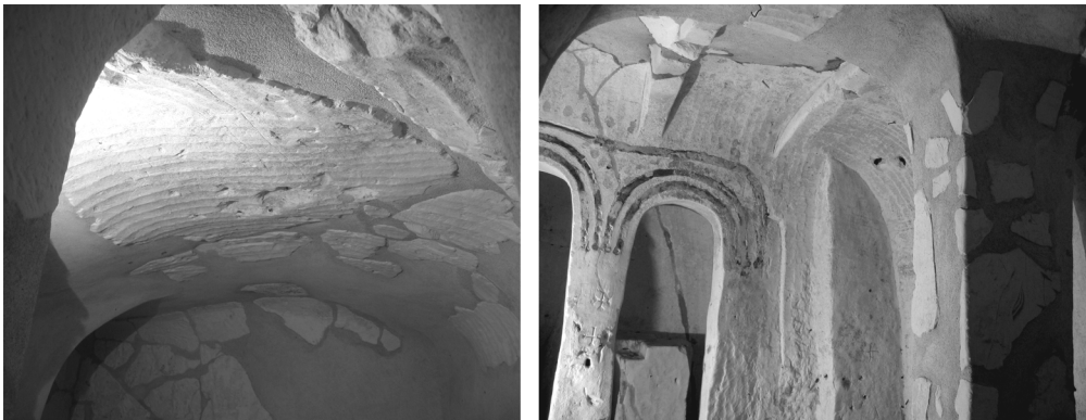
Fig. 9 – a) Plafond voûté du deuxième oratoire de l'église B3 / b) Plafond voûté de la partie sud-est de la nef de l'église B4.
