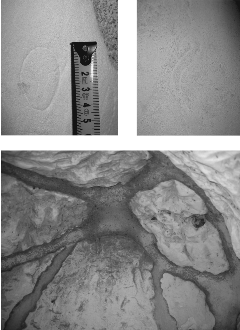
Fig. 15 – Chambres C1-2: a) Visage mongoloïde sur l'intrados gauche de la niche de la chambre C1 / b) La partie inférieure d'un dragon sur la paroi sud-est de la chambre C1 / c) Voûte de la chambre C2.
