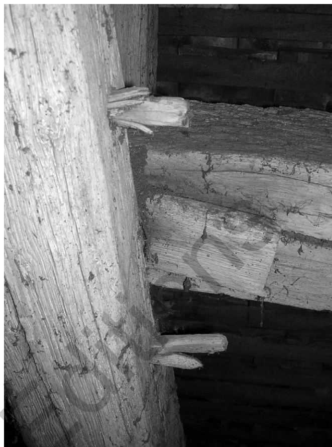
Fig. 20 Coins enfoncés dans la queue des chevilles et, en arrière-plan, cale pour l'ajustement d'une panne (cl. F. E.).
