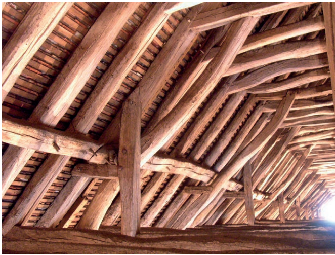
Fig. 14 Calage des pannes sur l'arbalétrier par le poteau latéral et son entretoise, assemblés à mi-bois au chevron (cl. F. E.).
