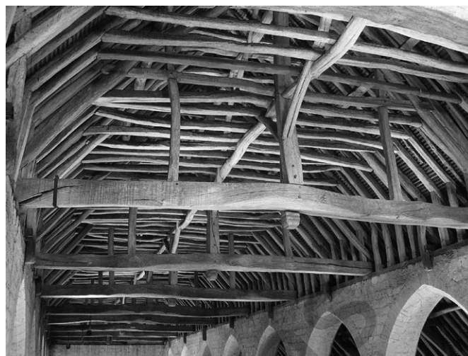
Fig. 7 Charpente du vaisseau principal (cl. F. E.).
