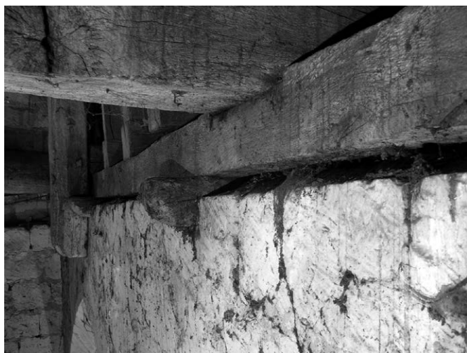
Fig. 12 Cale avec crochet sous les sablières sud (cl. F. E.).
