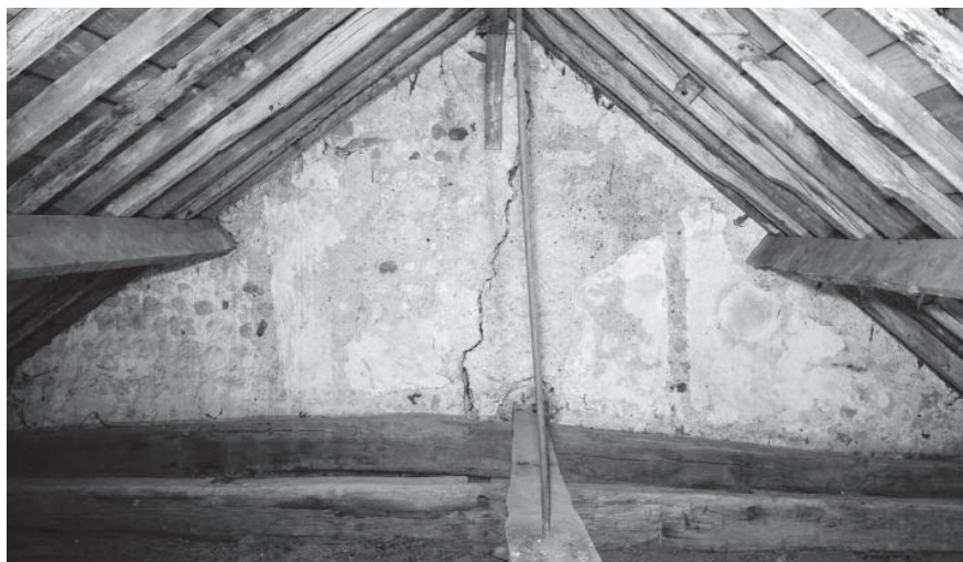
Fig. 11 - Rochecorbon, église Saint-Georges, vue intérieure du pignon ouest avec la trace en négatif de la première ferme et de ses potelets latéraux imprimés dans l'enduit.
