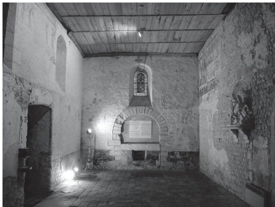
Fig. 4 - Rohecobon, église Saint-Georges, vue de la nef depuis le chœur.
