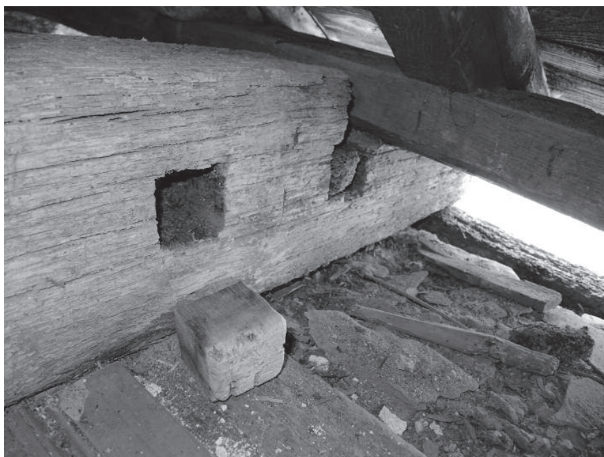
Fig. 12 - Rochecorbon, église Saint-Georges, flanc est de l'entrait E3 avec ses deux entailles carrées ayant conservé leur cales.
