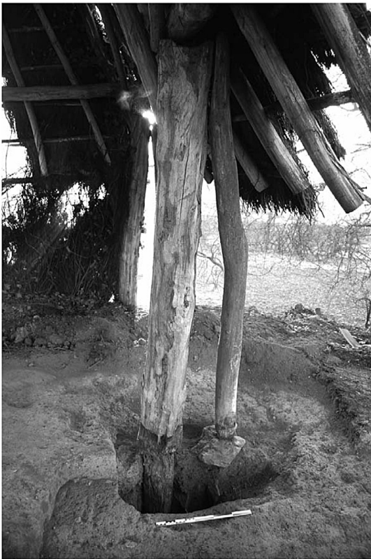
Fig. 48 Vihiers, « La Dauphinerie ». Cinquième poteau ouest avec son poteau oblique appuyé sur une pierre (cl. F. É.).
