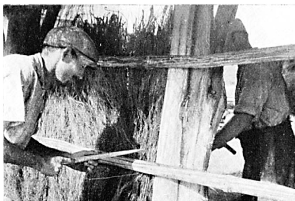
Fig. 61 Tissage des bottes des cloisons avec une aiguille en acacia (STEMMERMANN 1942).
