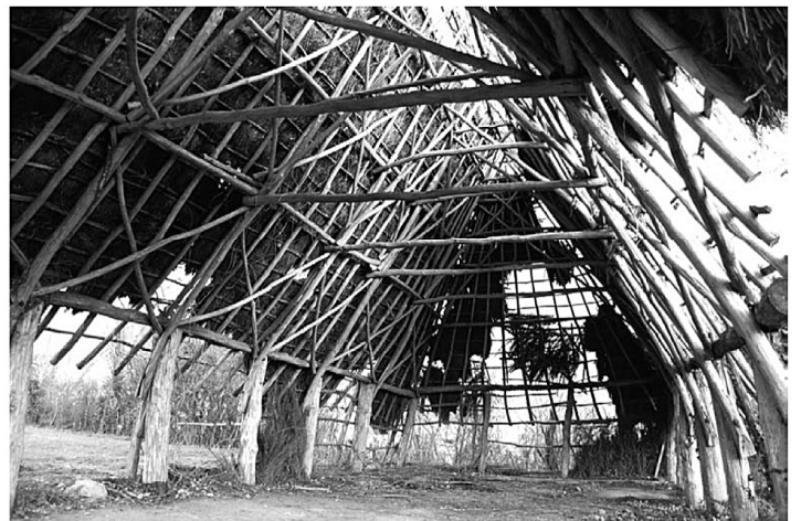
Fig. 43 Vihiers, « La Dauphinerie ». Charpente à fermes et pannes (cl. F. É.).
