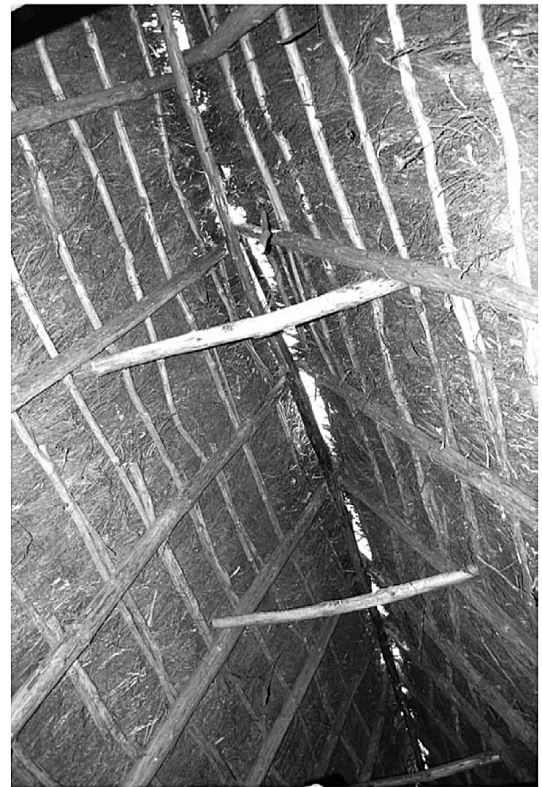
Fig. 11 Ambillou, «La Chaussée». Partie haute de la charpente (cl. F. É.).
