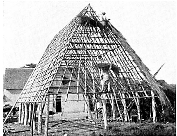
Fig. 59 Pose de la couverture en bruyère depuis un arêtier (STEMMERMANN 1942).
