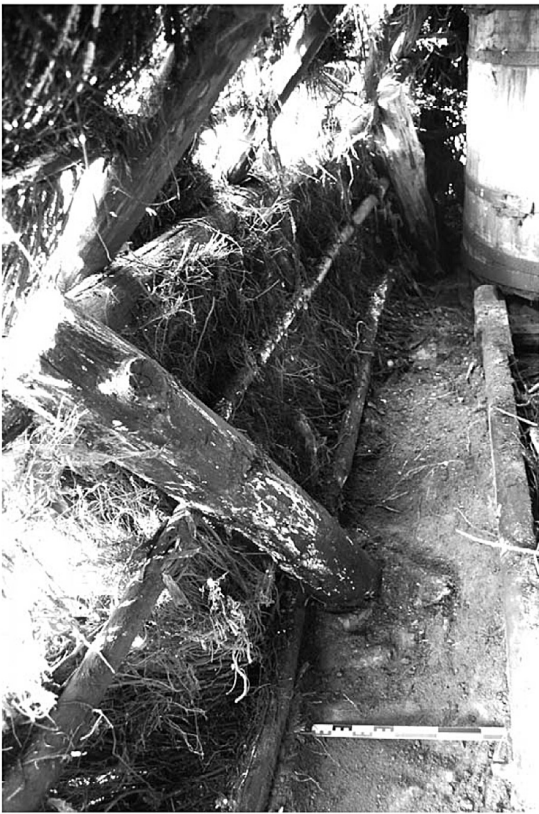
Fig. 26 Ambillou, « La Giberdière ». Cloison sur poteaux plantés (cl. F. É.).
