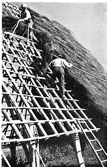
Fig. 60 Fixation des bottes en rangées verticales (STEMMERMANN 1942).
