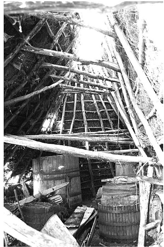
Fig. 24 Ambillou, « La Giberdière ». Charpente à chevrons-formant-fermes (cl. F. É.).
