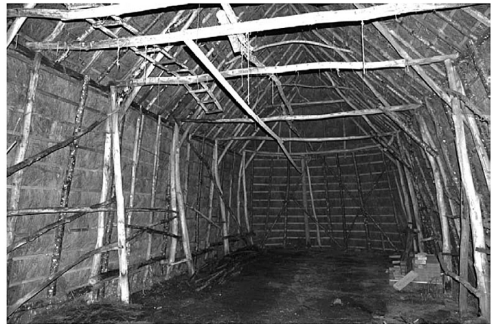
Fig. 40 Cléré-les-Pins, « Le Boulay », charpente constituée de perches (cl. F. É.).
