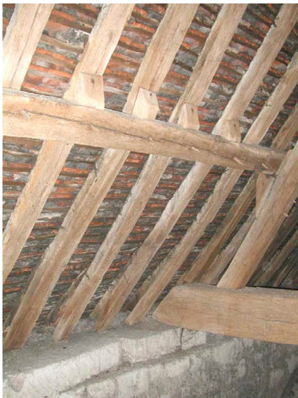
Fig. 48 : Villiers-le-Bel. Cales de butée des chevrons, XVI e s.
