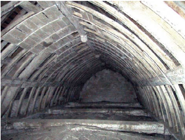
Fig. 52 : Église Saint-Pierre et Saint-Paul d'Arronville. Charpente de la nef, fin XV e s.
