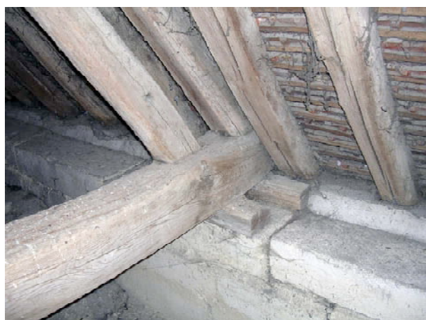
Fig. 43 : Champagne-sur-Oise. Pose sur cale de la ferme sur le mur, 1234d.
