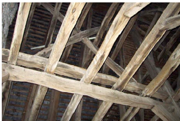
Fig. 30 : Bessancourt. Double liernes et croisée d'écharpes.
