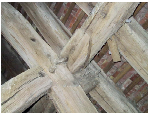
Fig. 42 : Champagne-sur-Oise. Assemblage des pannes au droit d'une ferme, 1234d.
