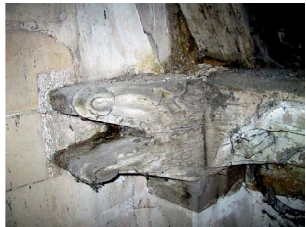
Fig. 55 : Arronville. Blochet sculpté en forme d'engoulant, fin XV e s.
