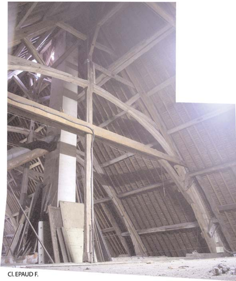
Fig. 32 : Abbaye de Royaumont. Comble du dortoir des convers. Ferme de la charpente voûtée du XIII e s. réemployée au XIX e s.
