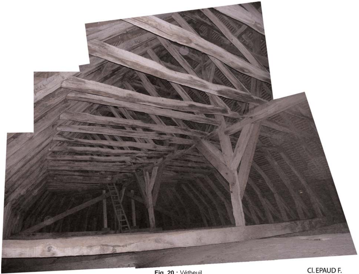
Fig. 20 : Vétheuil. Charpente du chœur, 1210-1212d.
