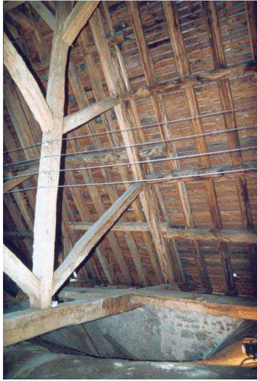
Figure 9 – Rapport entre les deux campagnes : rupture des cours de pannes, espacement distincts des chevrons, différences d'appareillage... Cliché F. Épaud.
