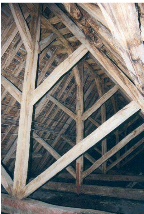
Figure 5 – Vue générale de la charpente de la nef. Cliché F. Épaud.
