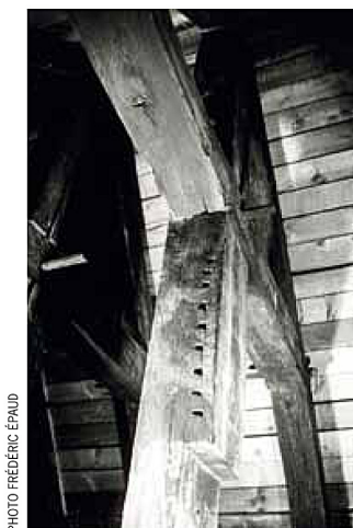
Marque à encoches sur un poinçon réemployé (4) et négatif des voliges de la couverture sur un chevron réemployé (5).
