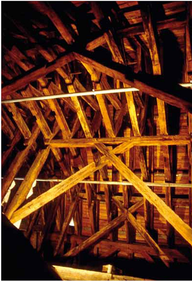
9. Liernes longitudinales soutenant les entrails retroussés des fermes secondaires.
