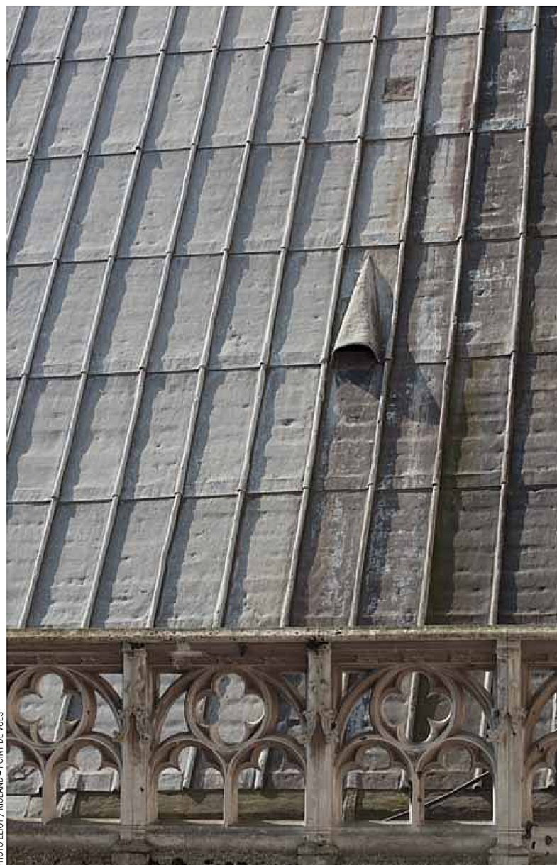
12. Tables de plomb des travées ouest de la nef épargnées par l'incendie de 1822. Leurs bords latéraux sont enroulés comme probablement pour les tables des XII e -XIII e siècles.
