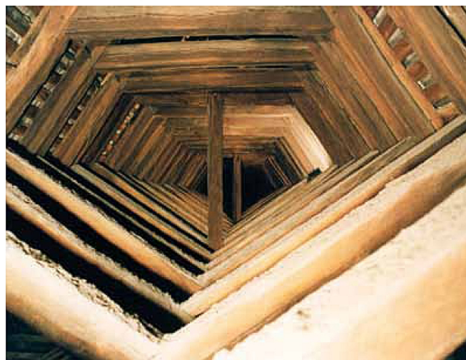
7. Charpente de la nef (1227-1232d).
