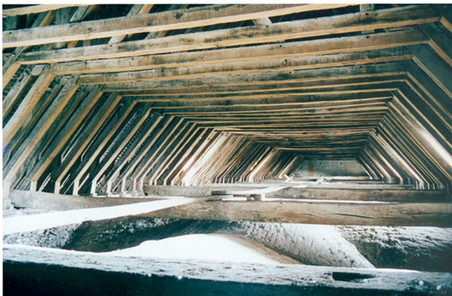
Fig. 7 Vue de la charpente de la nef, vers l'est
