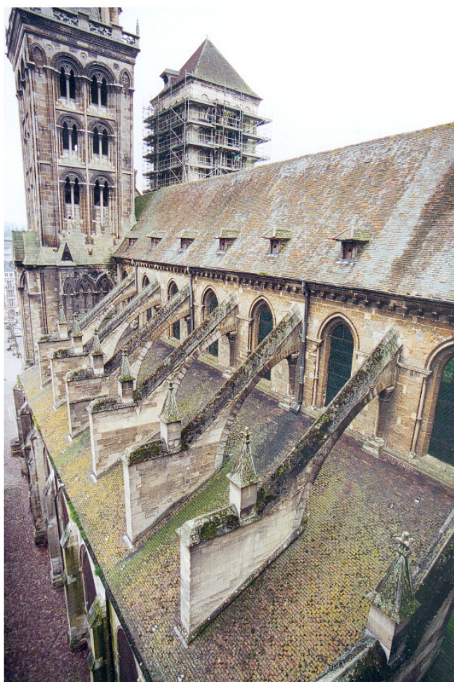
Fig. 3 Vue du bas-côté sud de la nef
