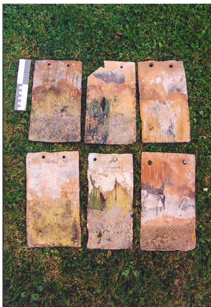
Fig. 26 Tuiles vernissées en réemploi dans les couvertures du croisillon nord
