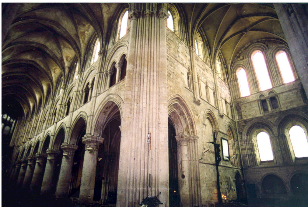
Fig. 2 Vue de la nef et du croisillon nord
