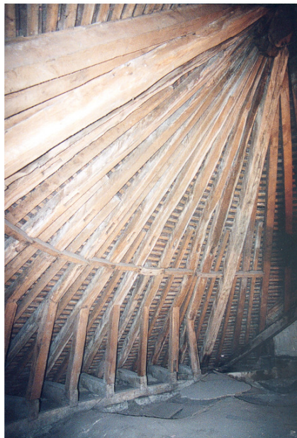
Fig. 25 Charpente de la chapelle nord
