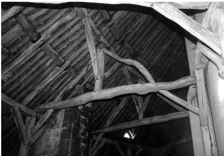
Figure 7: Bois tors du déambulatoire de la cathédrale de Bayeux. Vers 1220 (cliché F. E.)
