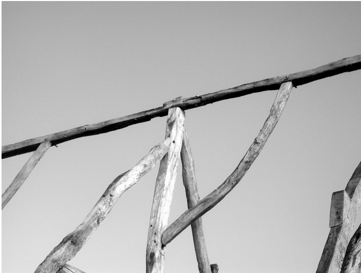
Figure 12 : Maison à pan de bois en cours de restauration. Pays de Bray, Oise. XIX e siècle. L'abondance des bois tors ne laisse que peu de doute sur leur origine bocagère (cliché Y. LD.)
