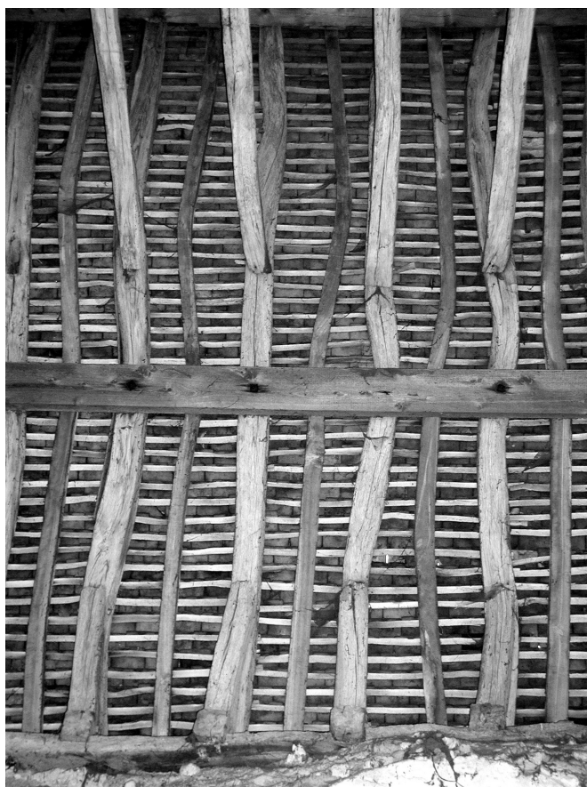
Figure 10: Chevrons tors de la chapelle Saint-Julien de la ferme de Vaux, Gisors, Eure. 1224. (cliché Y. LD.)
