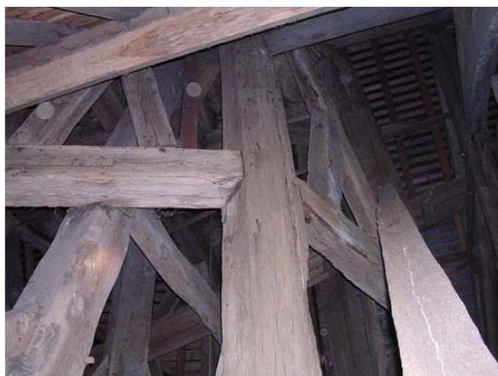
Etage du beffroi primitivement extérieur, couvert de clous du voligeage de sa couverture d'origine.
