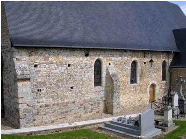
Les maçonneries du XV<sup>e</sup> siècle de la 1<sup>ère</sup> travée sont assisées en grès pour renforcer le mur destiné à supporter en partie les sommiers du clocher, pris dans le mur. Deux puissants contreforts épaulent ces murs au nord et sud, au droit du beffroi, pour étayer ces maçonneries.
