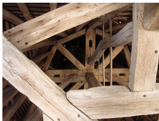
Seconde enrayure avec contrefiches et poinçon moisés
