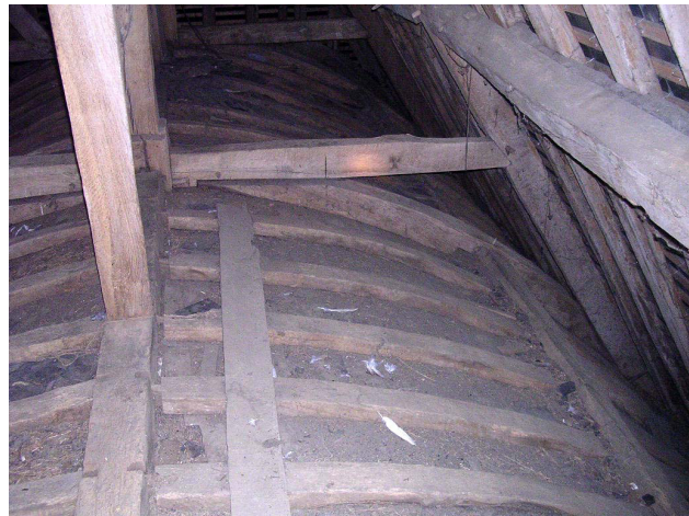
Charpente du chœur et cerces courbes de la voûte
