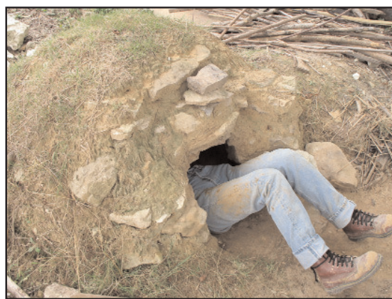
Fig. 178 a et b: réfection de la voûte par application de torchis
