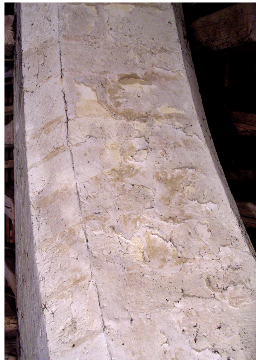
Fig. 18 Intrados de l'arcade de la 4ème travée sud, enduit peint recouvrant l'appareillage.
