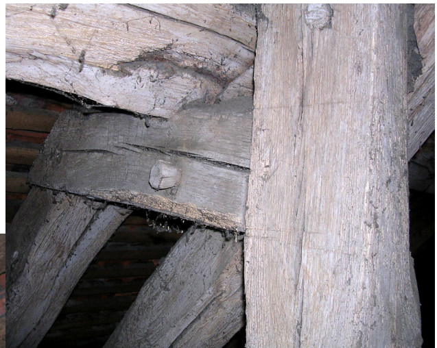
Fig. 102a Tracés de piquage au traceret sur le poteau dans le prolongement de l'entretoise
