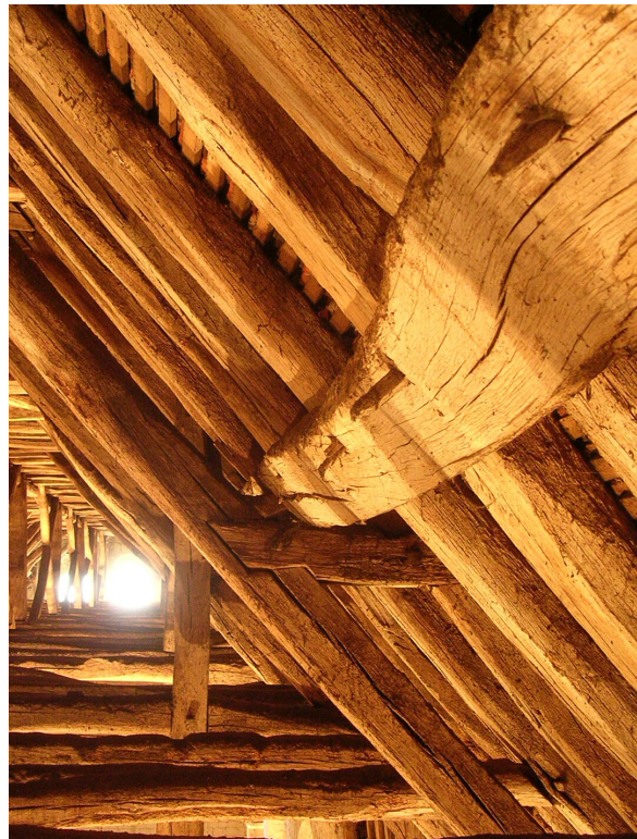
Fig. 65 Chevillage perpendiculaire des chevrons à la panne
