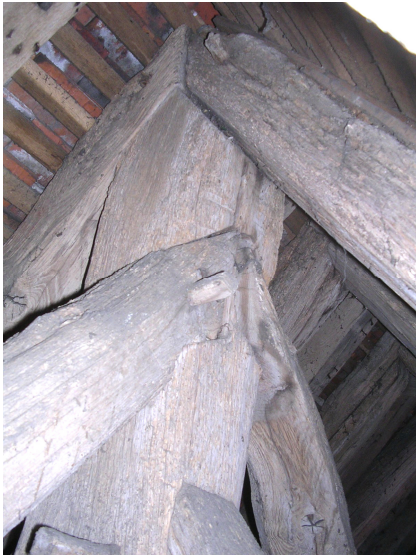
Fig. 69 Assemblages des écharpes au poinçon
