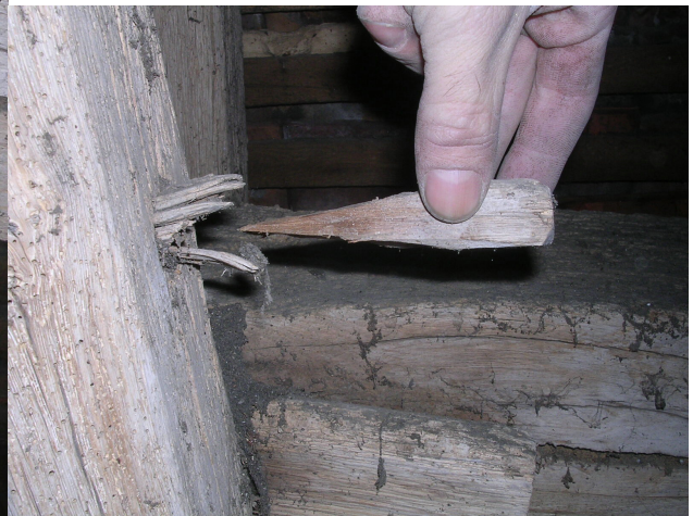
Fig. 114c Coin extrait du logement
