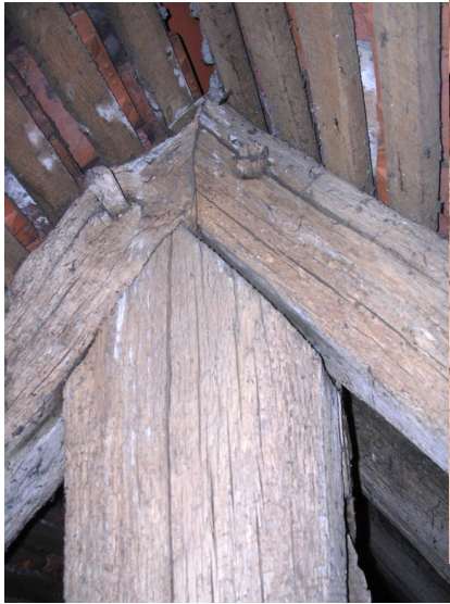
Fig. 47 Faux entrants de F8, face ouest
