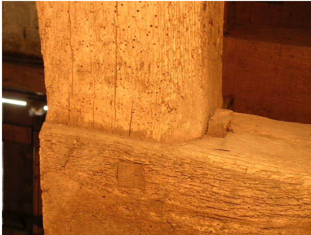
Fig. 96 Coin enfoncé dans la mortaise du blochet
