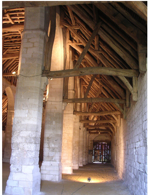
Fig. 75c Charpente d'une travée du bas-côté nord Fig. 76 Bas-côté sud, vue de l'ouest
