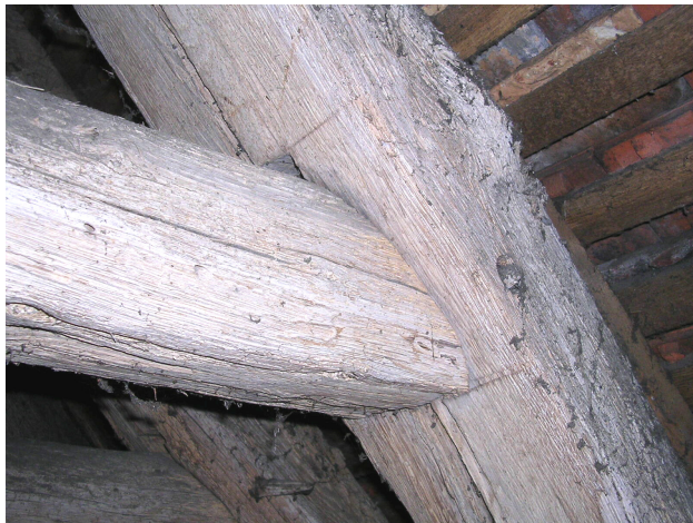
Fig. 102b Tracés de piquage sur le chevron au droit de l'assemblage du faux entrait
