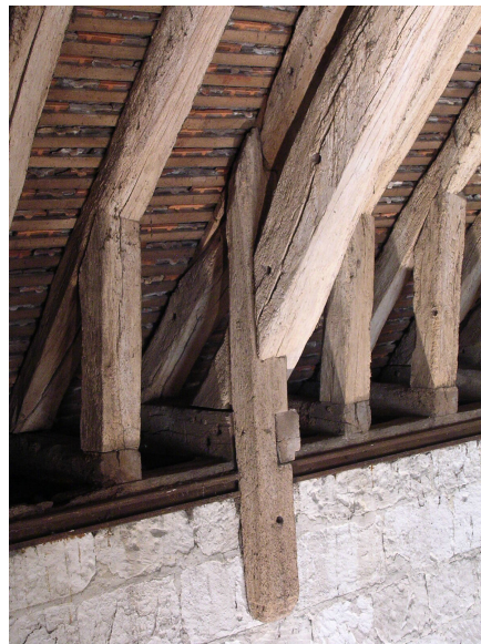
Fig. 89 Jambe de force en butée
