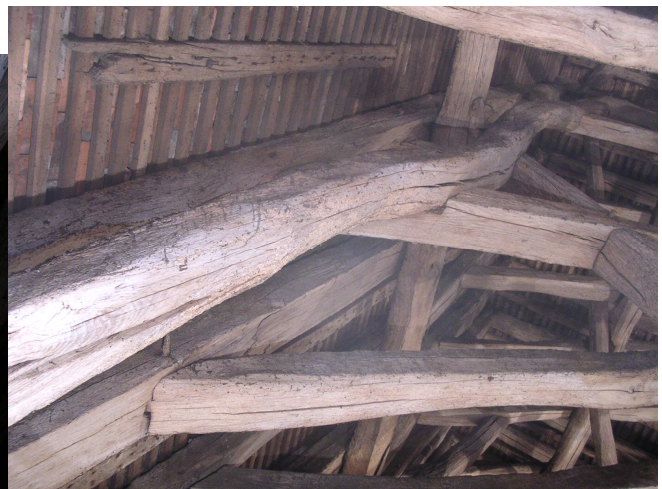
Fig. 50 Arbalétrier sud, face est
