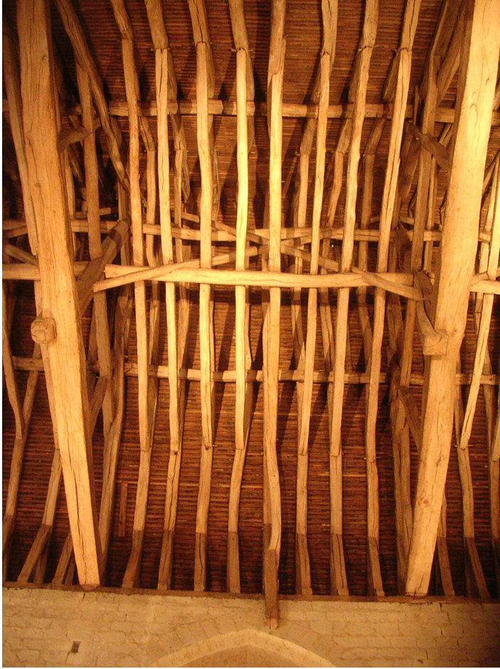
Fig. 60 Vue de la 7ème travée avec ses 7 fermes secondaires et 1 ferme intermédiaire
