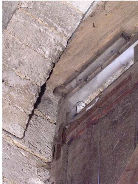
Logement de l'axe de la porte dans le linteau
