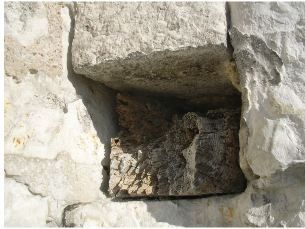
Corbeau en place dans son logement
