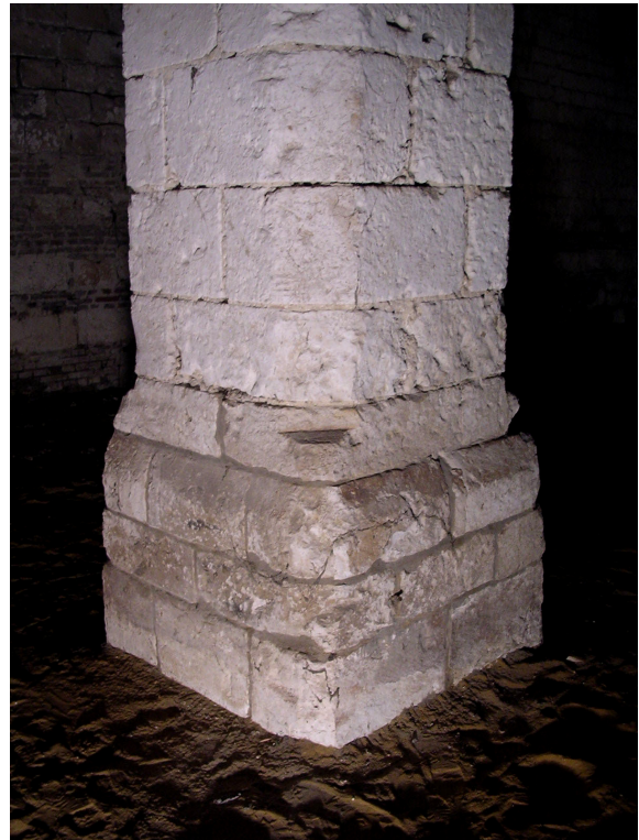
Fig. 16 Base d'une pile.
