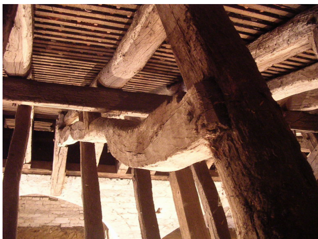
Fig. 57 Arbalétrier tors d'une ferme intermédiaire
