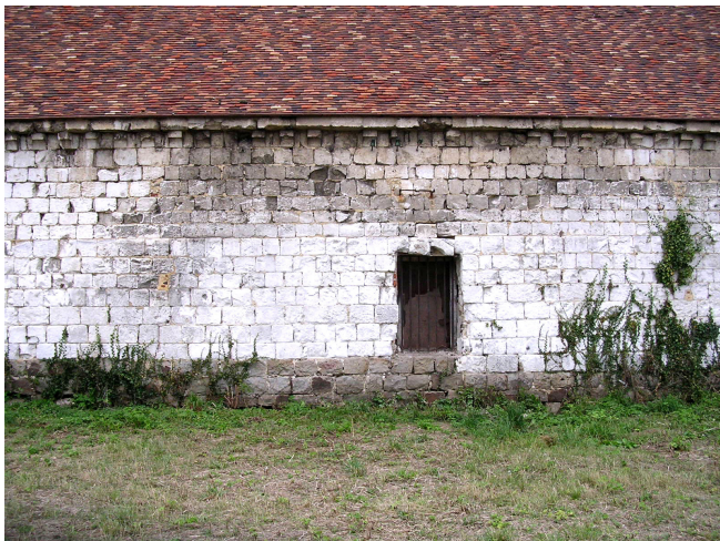
Fig. 10 Mur gouttereau sud.
