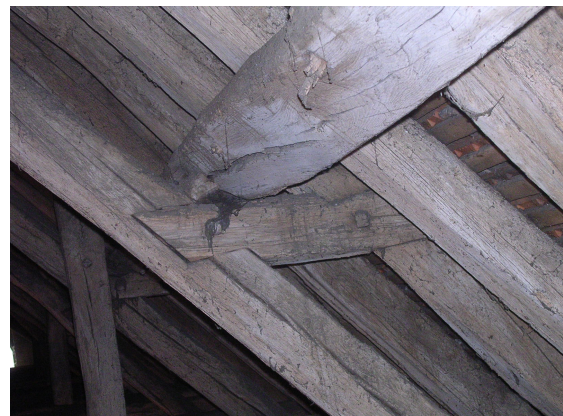
Fig. 58 Etrésillon assemblé à mi-bois
