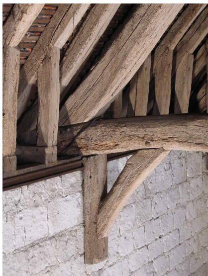
Fig. 83 Console travaillant en butée contre le mur
