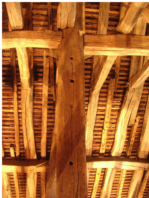
Fig. 111 Trous d'échelier percés dans le flanc d'un poinçon
