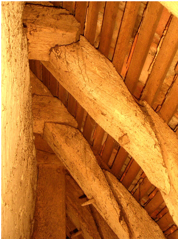
Fig. 64 Enture biaise en pied des chevrons
