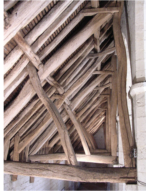
Fig. 82 Cale sous l'entrait
