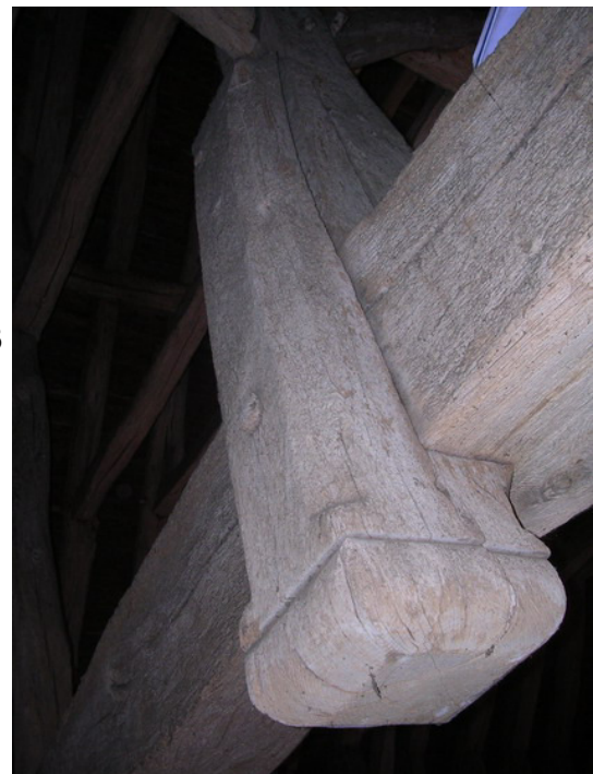
Fig. 52c Suspente de F3
