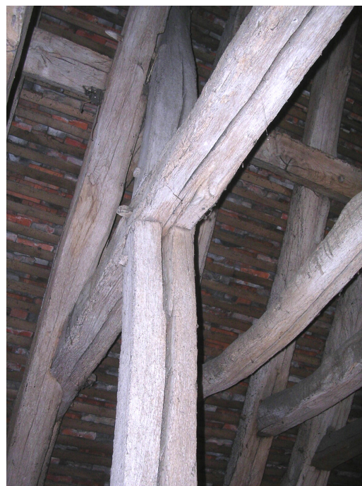
Fig. 115a Chevillage du poteau fendu de part et d'autre de l'assemblage
