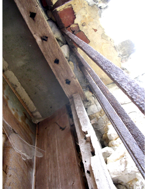
Fig. 23 Linteau et montant de la baie
