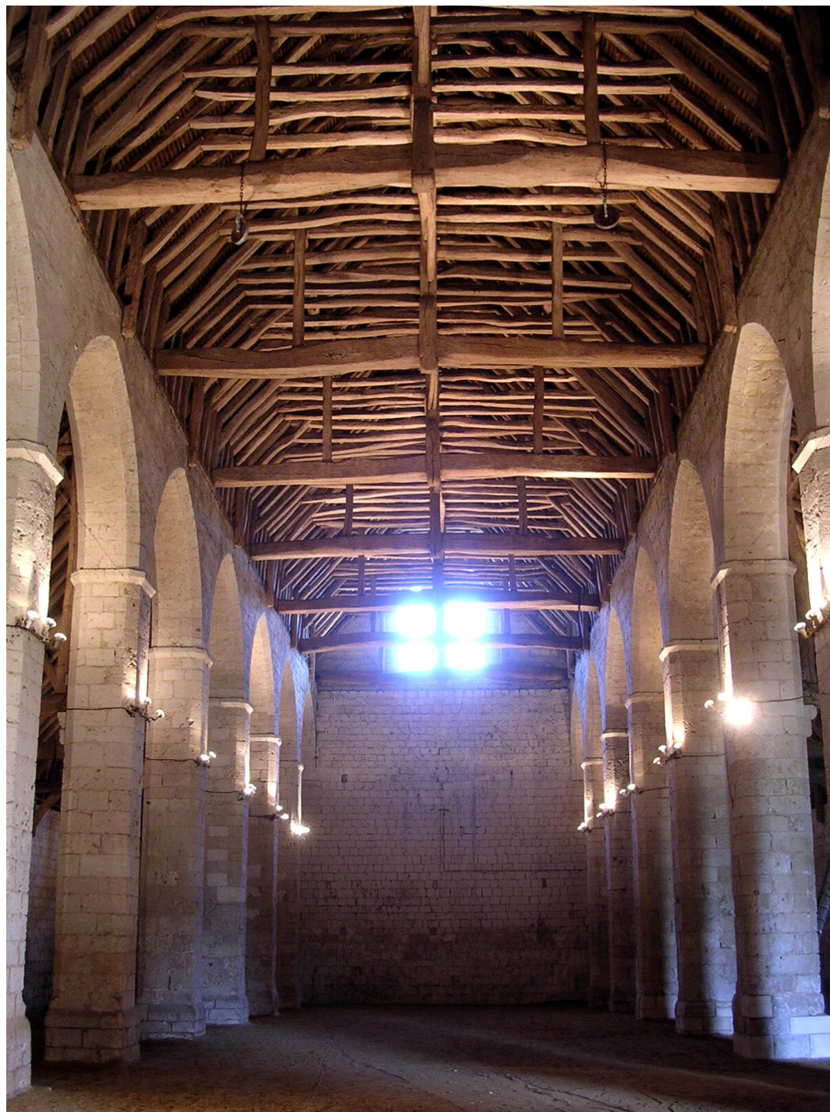
Fig. 14 Intérieur de la grange, vue des deux files d'arcades de la nef.
