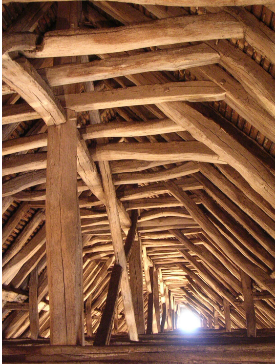
Fig. 66 Cours des liernes supérieures raidies par les croisées d'écharpes assemblées à mi-bois
