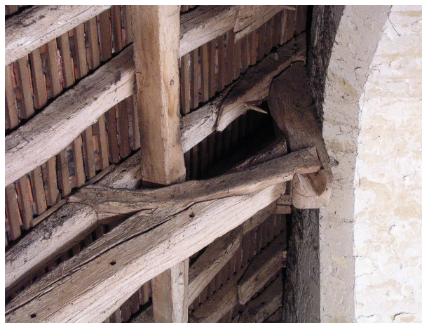
Fig. 91 Assemblages de tête de la demi-ferme
