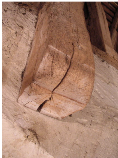
Fig. 55a Jambe de force avec son about mouluré d'une ferme intermédiaire
