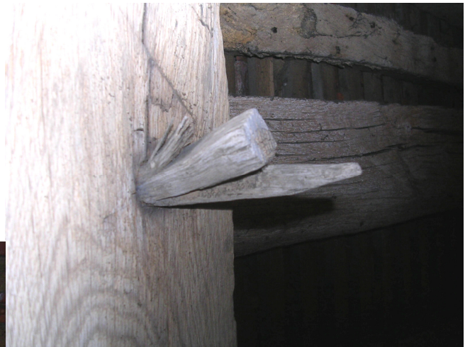
Fig. 114a Coin enfoncé à l'encontre d'une cheville
