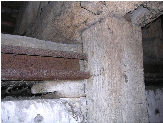
Fig. 79c Extrémité de la cale débordante, travaillant en butée contre le mur
