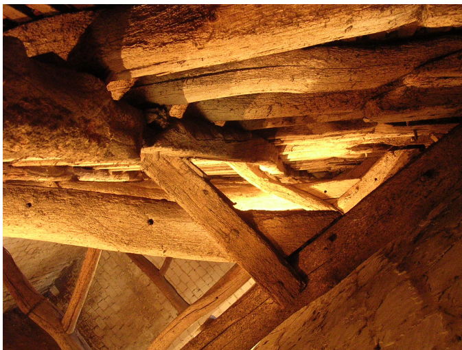
Fig. 33 Bas-côté nord : panne torse et poteau évitant le ressaut de la pile
