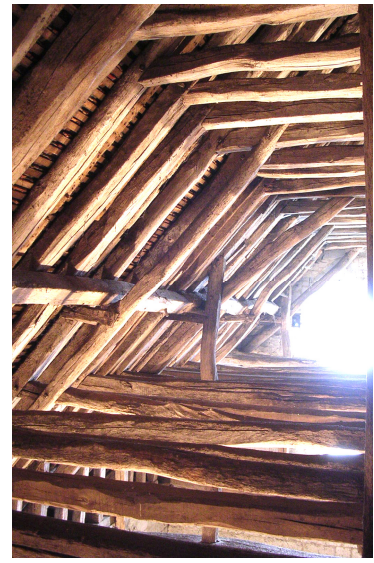
Fig. 54 Ferme intermédiaire située en milieu de travée pour soutenir les pannes
