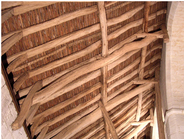
Fig. 88 Demi-ferme intermédiaire nord, travée 7
