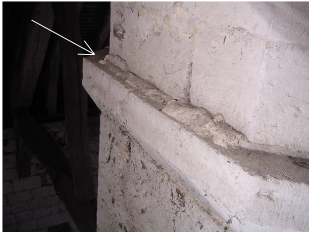
Fig. 17 Négatif d'une pièce du cintre dans le mortier.
