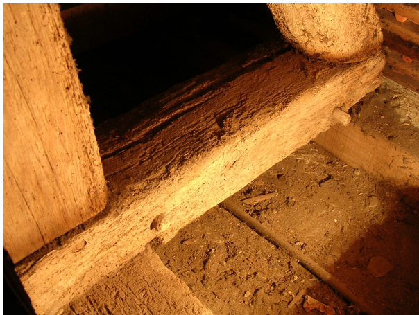
Fig. 110 Trou percé aux extrémités des liernes de part et d'autre du poinçon
