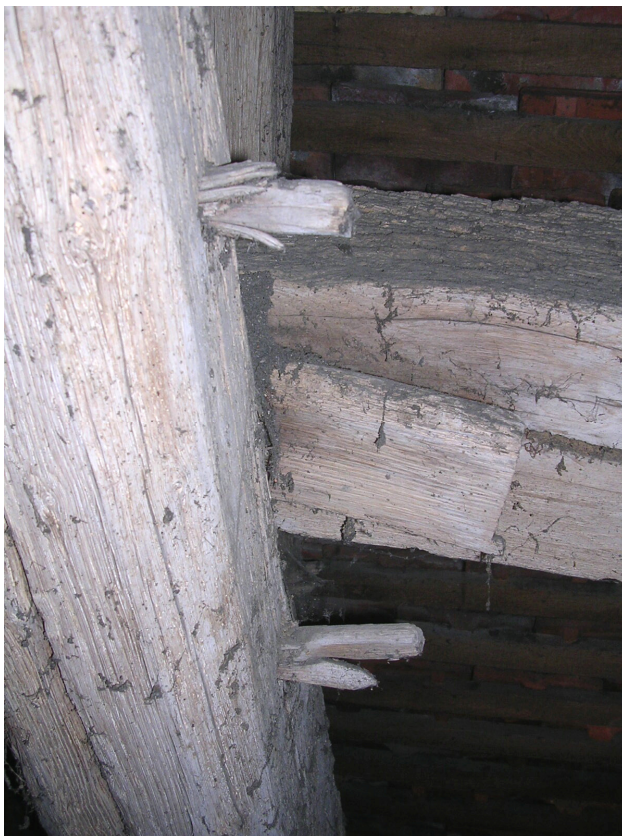
Fig. 114b Coins enfoncés à force à l'opposé des chevilles pour bloquer l'assemblage
