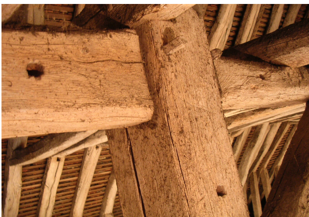
Fig. 112 Trous d'échelier dans les arbalétriers des fermes des bas-côtés
