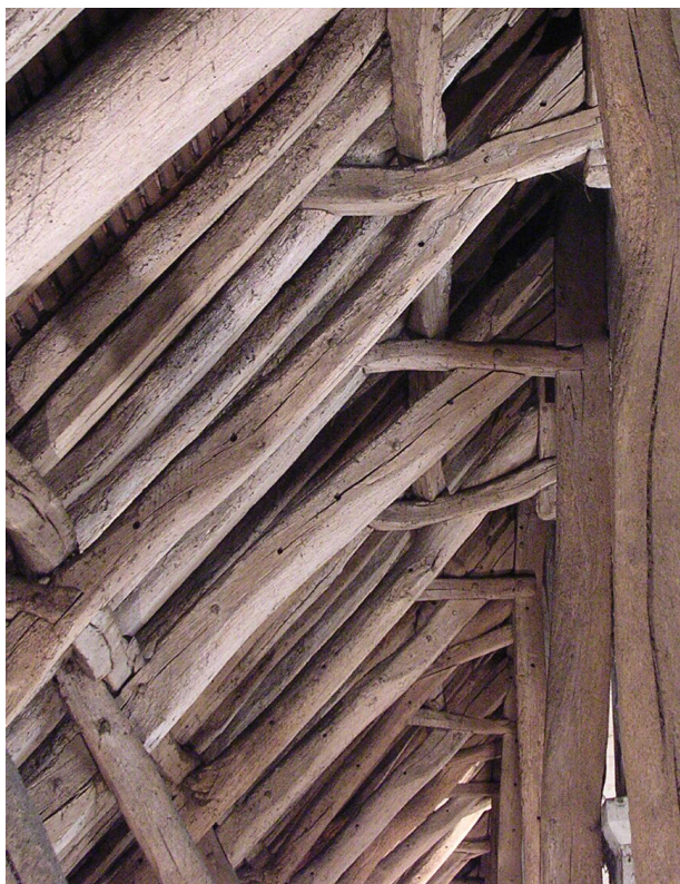
Fig. 112 Trous d'échelier dans les arbalétriers des fermes des bas-côtés
