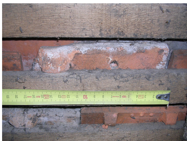
Fig. 117 Tuile en réemploi présentant un crochet désaxé et un trou destiné à un clou pour la réutilisation de la tuile en cas de rupture du crochet
