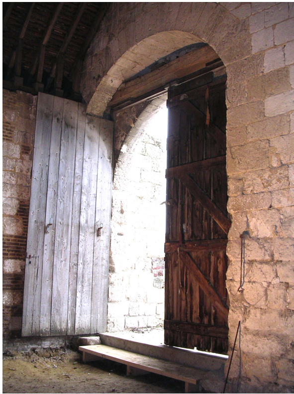
Logement de l'axe dans le seuil en grès
