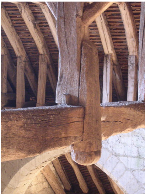
Fig. 52c Suspente de F3
