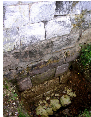
Fig. 11 Fondations du mur gouttereau nord
