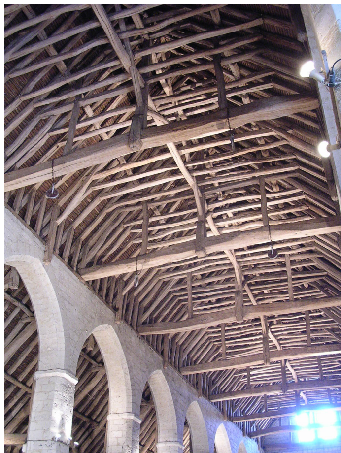
Fig. 34 Charpente de la nef
