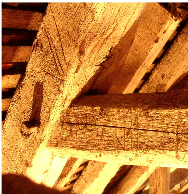
Fig. 99 Marques d'assemblage reportées sur l'autre bois au droit de l'assemblage
