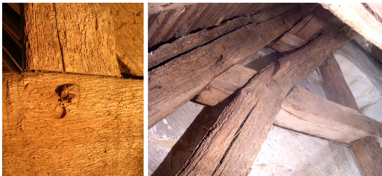
Fig. 107 Chevillage de la ferme 10 orienté vers l'intérieur
