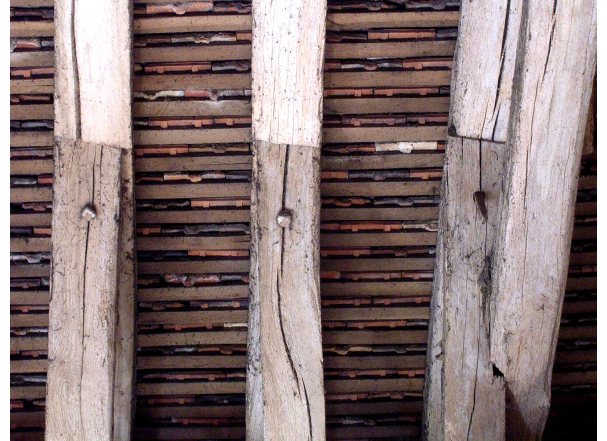
Fig. 61 Embrèvement biais des jambes de force aux chevrons, chevillage de l'intérieur
