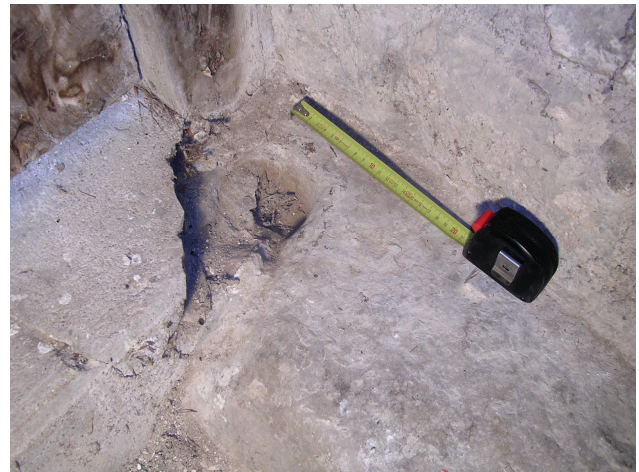
Logement de l'axe dans le seuil en grès
