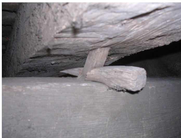
Fig. 116 Cale placée entre un chevron et la panne, percée par le chevillage du chevron
