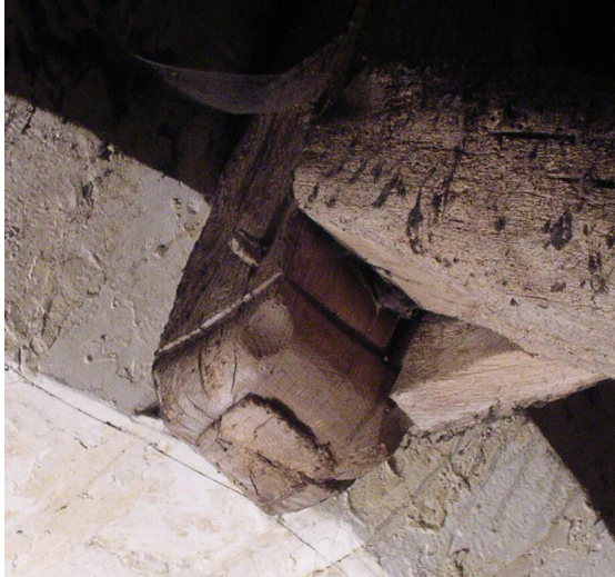
Fig. 93 Sculpture en about de la culée, 1 ère travée Fig. 95 Embrèvement des jambes de force aux chevrons
