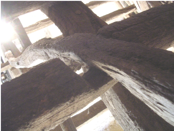
Fig. 70b Profonde entaille de l'entrait retroussé pour le passage de l'écharpe torse
