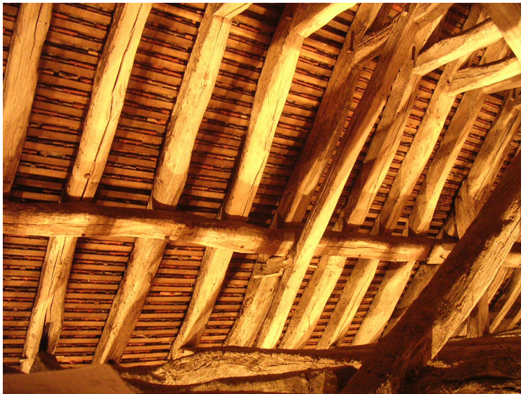
Fig. 54 Ferme intermédiaire située en milieu de travée pour soutenir les pannes
