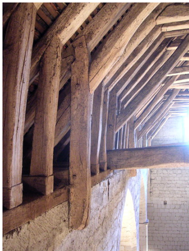
Fig. 55a Jambe de force avec son about mouluré d'une ferme intermédiaire
