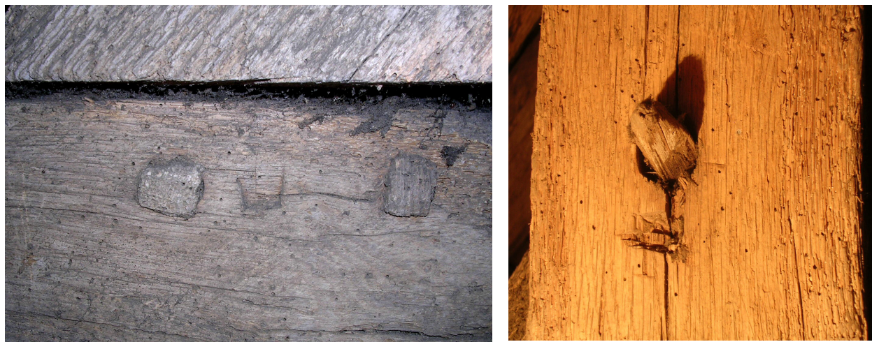
Fig. 104 Amorce d'un percement de trou de cheville à la tarière
