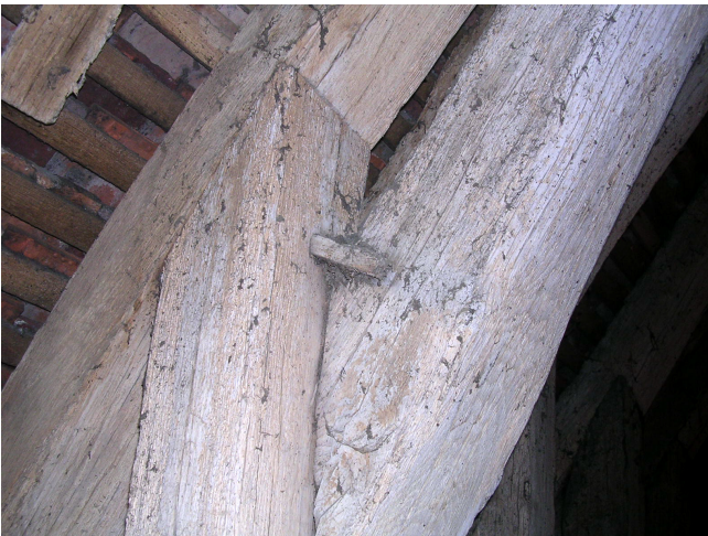
Fig. 49 Embrèvement biais chevillé de la jambe de force de F 5, face ouest
