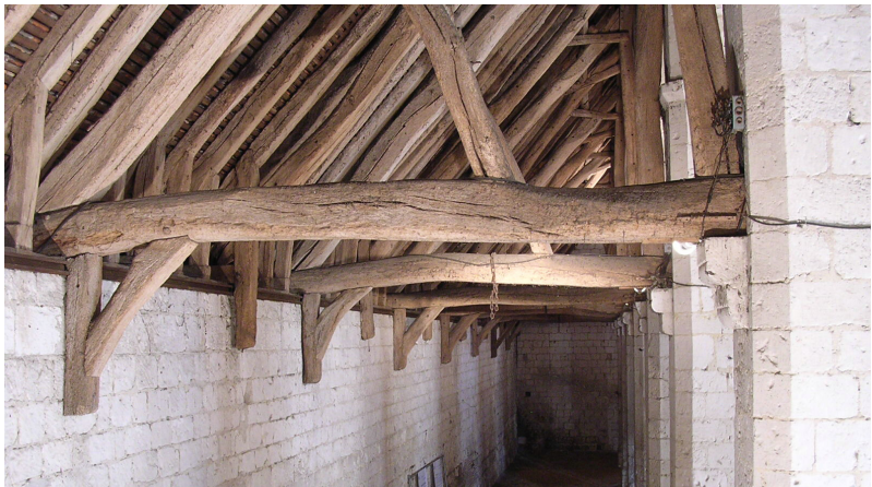
Fig. 84 Entrails tors du bas-côté nord, incurvés vers le haut
