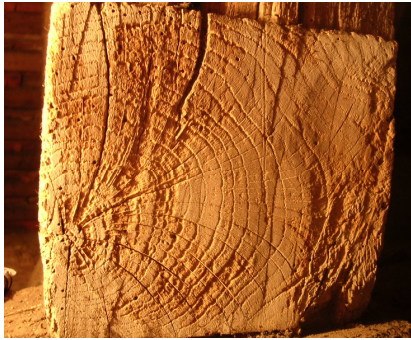
Fig. 30 Taille de l'about d'un blochet à la hache
