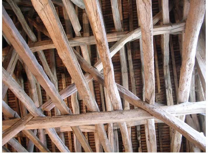
Fig.67 Liernes inférieure et supérieure assemblées par mi-bois aux écharpes
