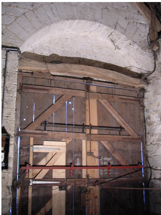
Fig. 27 Porte est, linteau en place ancré dans le mur aux extrémités
