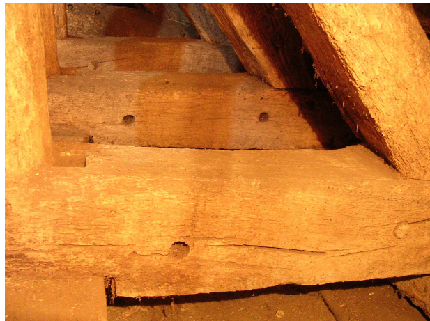
Fig. 109 Double trous de cheville dans le flanc est des blochets
