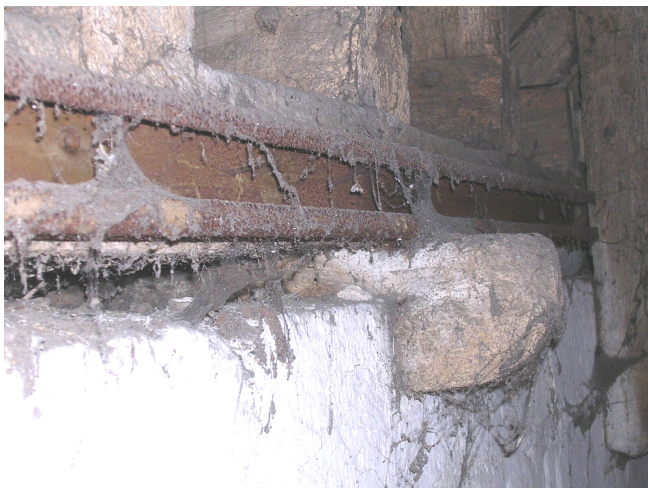
Fig. 79c Extrémité de la cale débordante, travaillant en butée contre le mur
