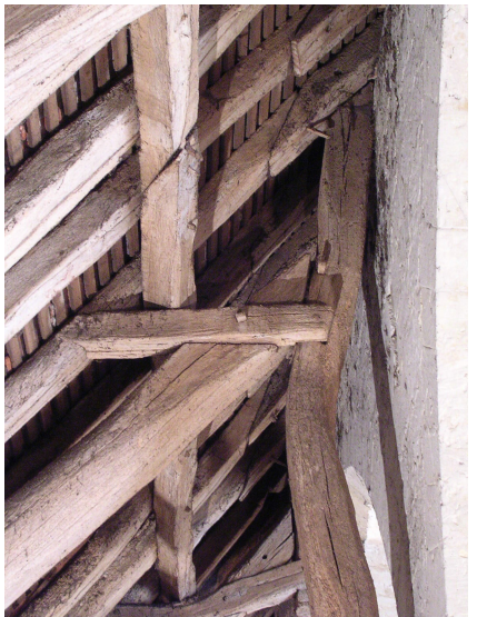
Fig. 81c Partie haute d'une demi-ferme de bas-côté nord
