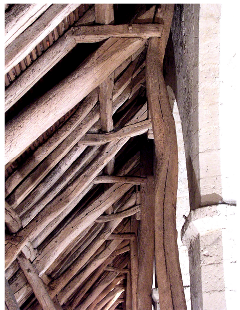
Fig. 33 Bas-côté nord : panne torse et poteau évitant le ressaut de la pile
