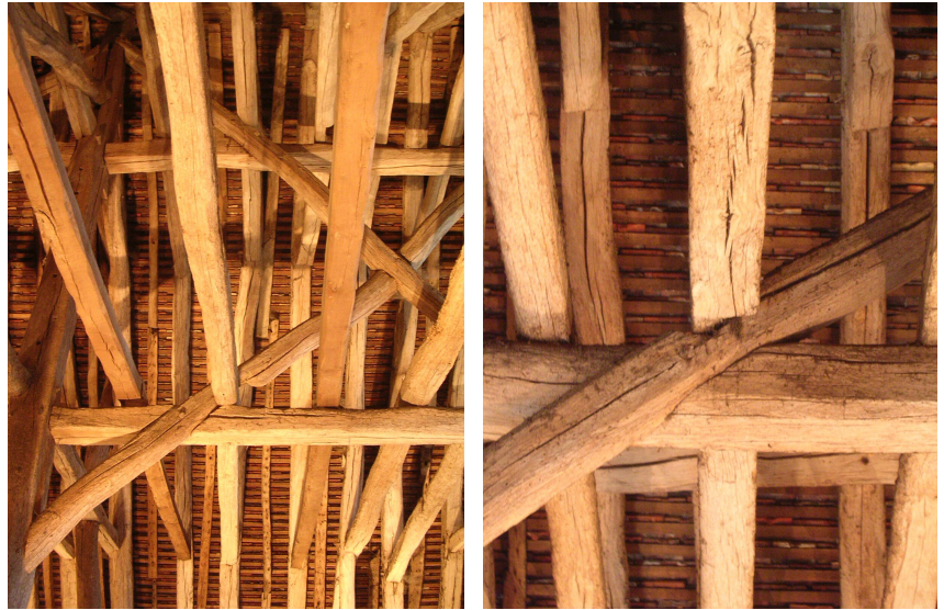
Fig. 70b Profonde entaille de l'entrait retroussé pour le passage de l'écharpe torse
