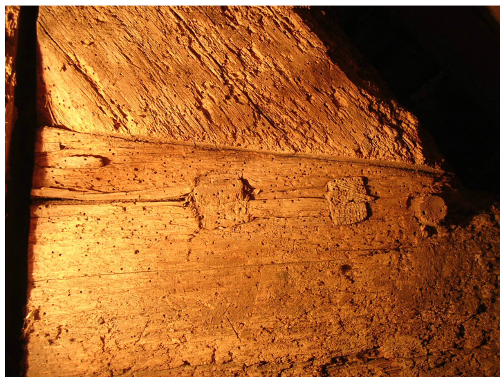
Fig. 115b Chevilles destinées à limiter la déformation des fentes du poteau
