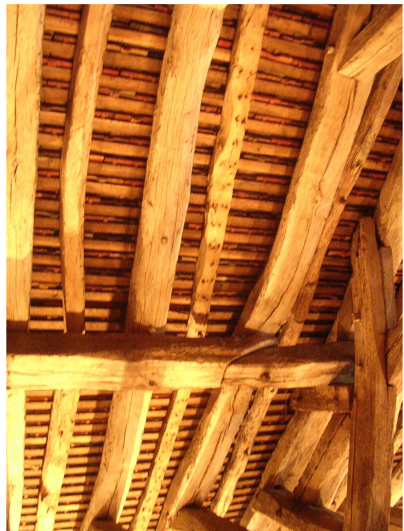
Fig. 71 Enture biaisée du cours des pannes
