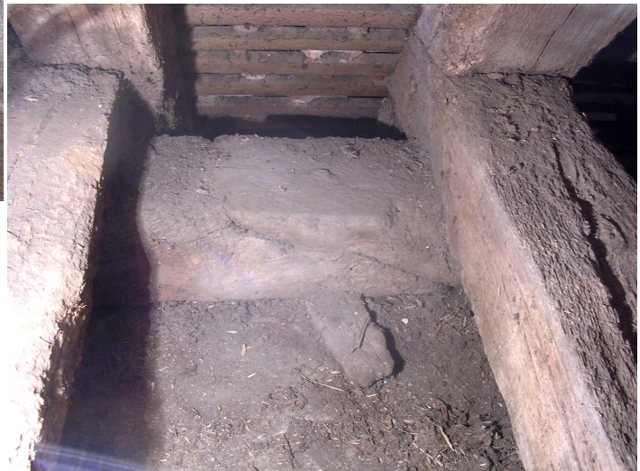
Fig. 38c Cale placée sur l'enture de sablières internes
