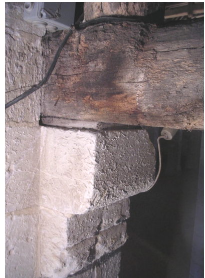
Fig. 82 Cale sous l'entrait
