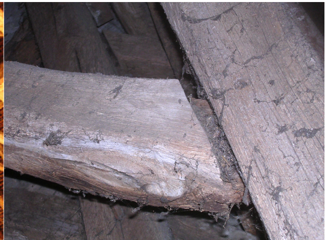
Fig. 48 Tenon de faux entrant, about biais
