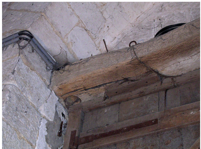
Porte est, logement circulaire de l'axe du vantail
