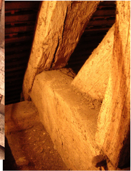
Fig. 48 Tenon de faux entrant, about biais
