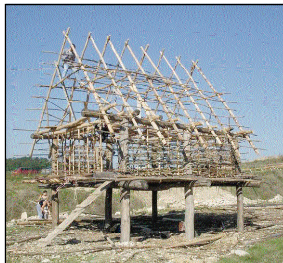
Fig. 134 et 135 : le grenier début septembre 2004 avant la mise en oeuvre du torchis et du chaume
