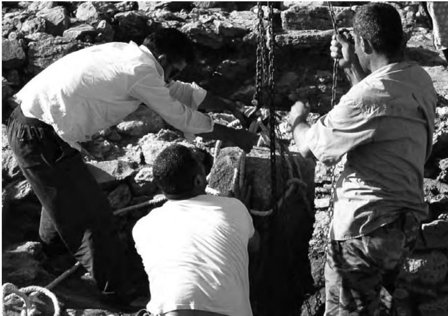
*Fig. 5 – Enlèvement, à l'aide d'une chèvre, d'un gros bloc de pierre de taille (73 x 44 x 35,5 cm)
