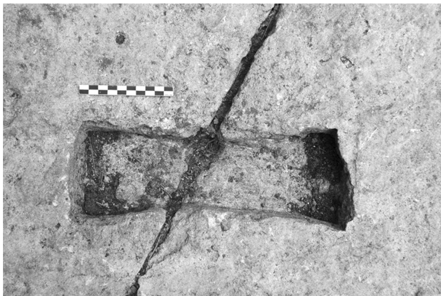
Fig. 15 – Cavité en forme de queue d'aronde, sur la pile centrale (cliché J.-C. Bessac).
