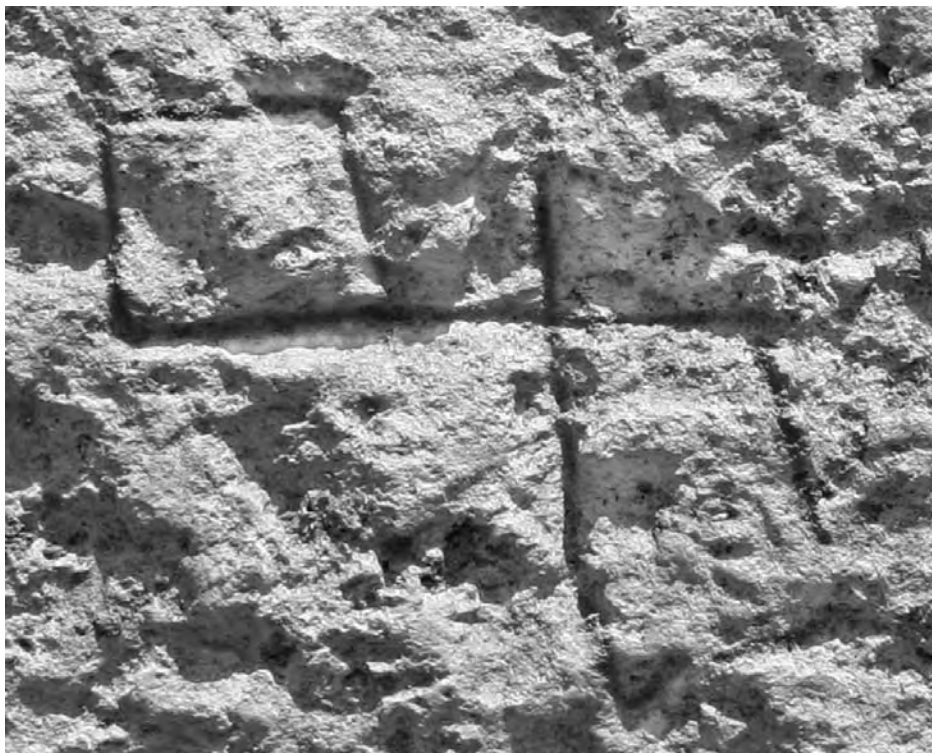
Fig. 35 – Marque lapidaire sur un des blocs de parement de la pile centrale (cliché J.-C. Bessac).
