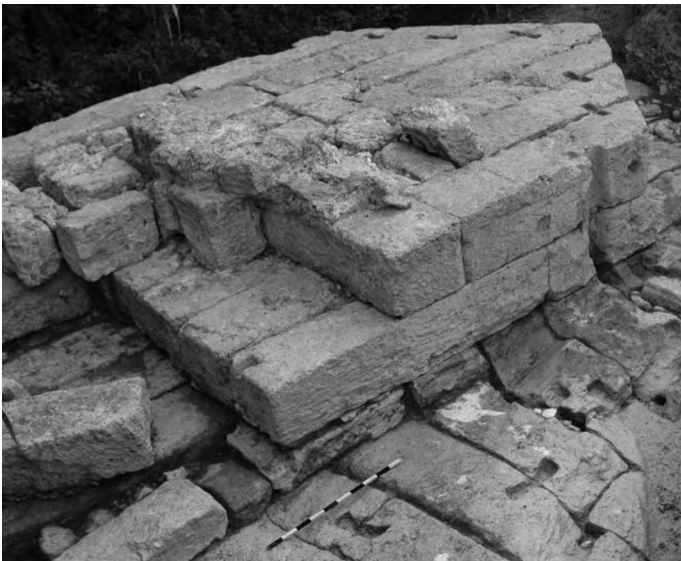
Fig. 20 – Moellons liés au mortier sur la pile centrale (© Mission de Ras Shamra, cliché V. Matoïan).
