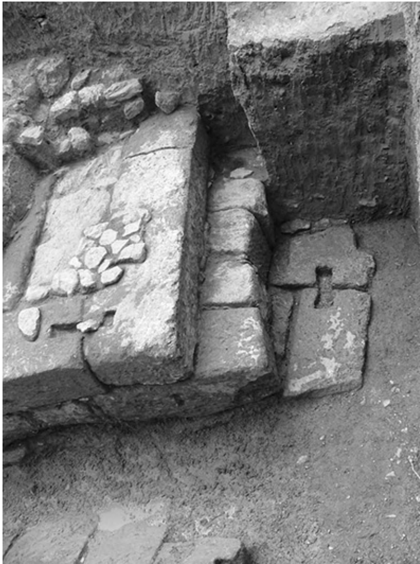
Fig. 23 – Partie aval du massif d’ancrage de rive gauche (© Mission de Ras Shamra, cliché F. Onnis).
