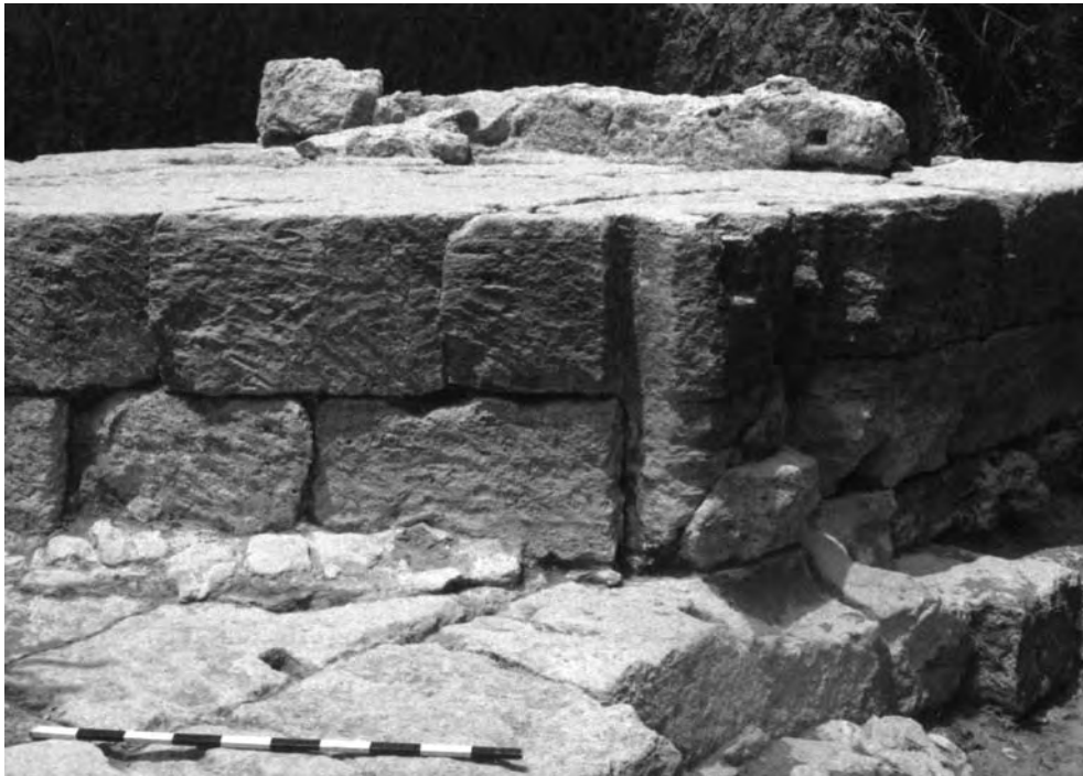
Fig. 19 – Feuillure verticale amont du côté nord de la pile centrale (© Mission de Ras Shamra).
