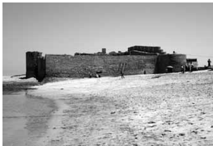
Aguz-Souira Kedima - La forteresse vue du port. La tour de l'angle sud-est protège également sa porte. Les crénelures sont récentes, réalisées lors d'une restauration dans les années 1980. Un nouveau chantier de restauration est en cours.
