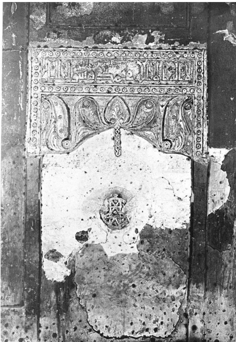
Photo 1 : Le mihrāb à l'étoile avant restauration
