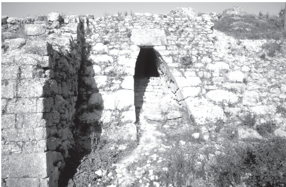
Fig. 3 - Vue de la poterne d'Ugarit (cliché V. Matoïan).
