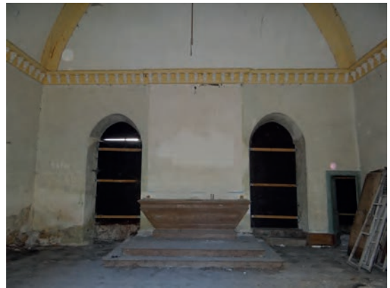
d. Mur intérieur sud de la chapelle.
