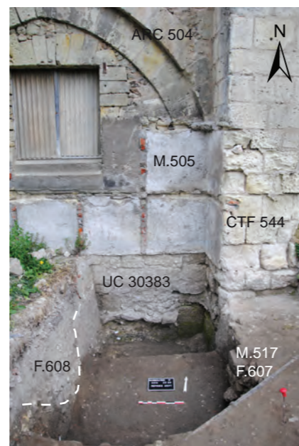
f. Mur 505, arc 504 et contrefort 544.
