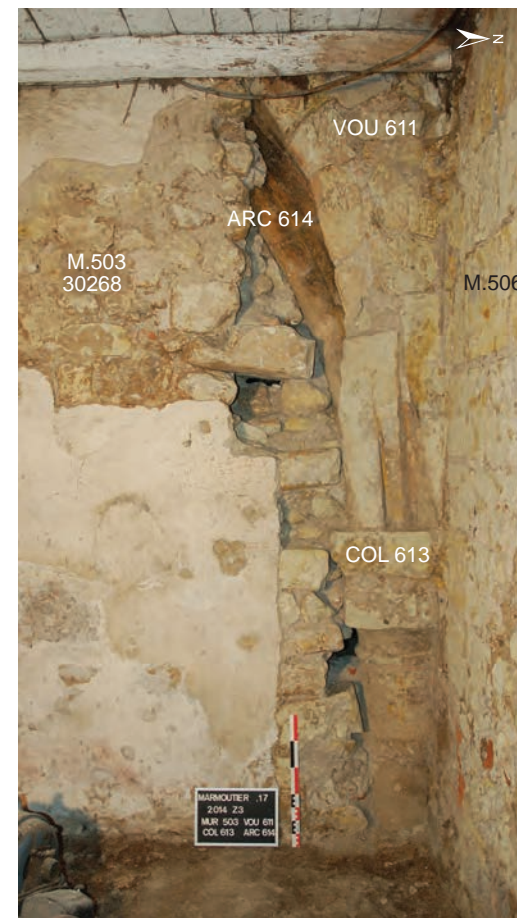
d. Mur 503, Colonne 613, Arc 614 et voûte 611, face est.
