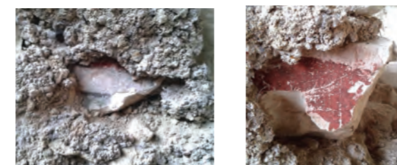
h. Enduit peint de la face est de la pile 251.
