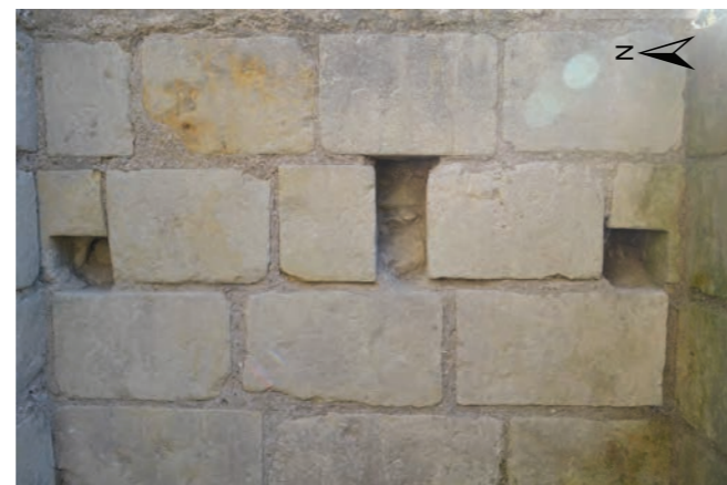
b. Détail des trous de boulin de l'EA 1379 (mur 1029).
