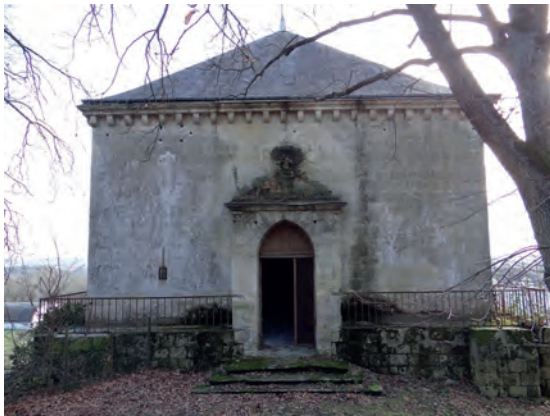
c. Façade nord de la chapelle.
