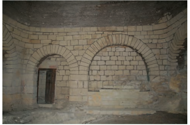
b. Mur ouest de la salle haute et son autel moderne.
