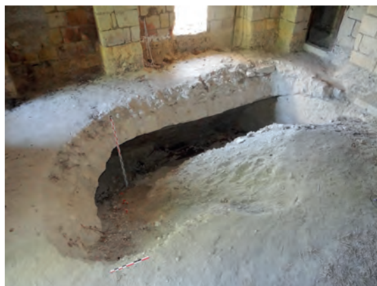
e. Effondrement du sol, vue du nord.
