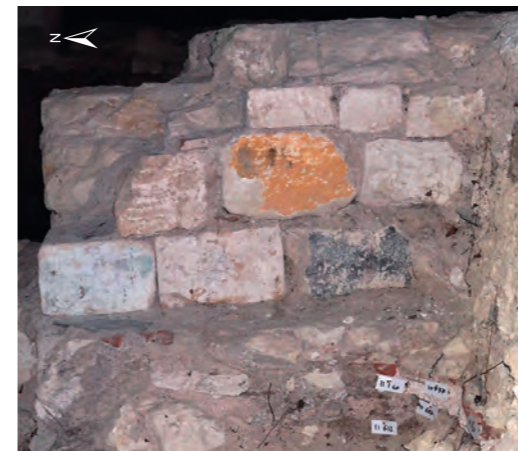
c. PIL.251. Massif de fondation, vue de l'ouest.
