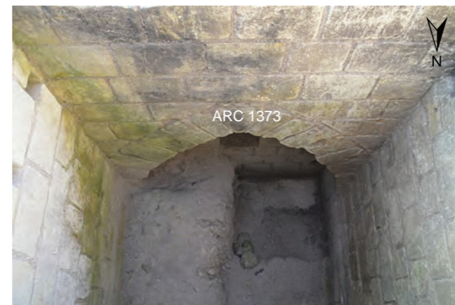
c. Vue du mur sud depuis le sommet du mur 1001.
