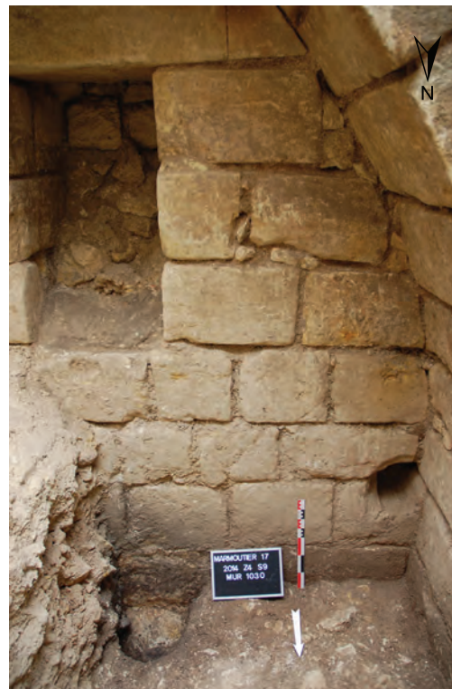
c. Mur sud de la latrine, US 43001 et 43003 en cours de fouille.
