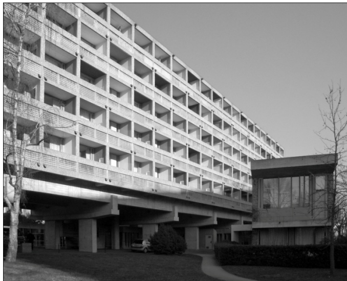
Figura 1. Casa de Brasil. Fachada sureste. Estado actual. 1
