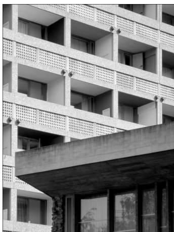
Figuras 4 y 5. Brise-soleil sureste y aérateur de planta baja. Estado actual.
