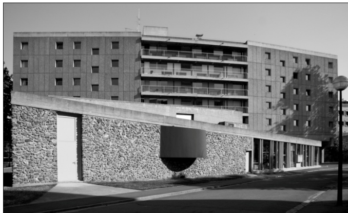
Figura 3. Fachada noroeste. Bloque y planta baja con pan de verre ondulatoire . Estado actual.
