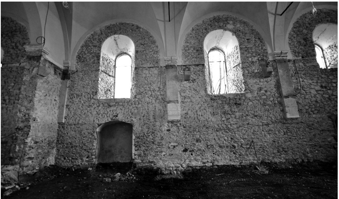
Fig. 4 : Mur gouttereau sud, deuxième et troisième travées de la nef, avec le niveau d'arrachement du plancher, cliché Nathalie Nicolas.
