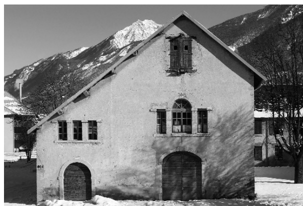
Fig. 2 : Façade de l'église avant le début des travaux, décembre 2010, cliché Marie Augustin (Ville d'Embrun).
