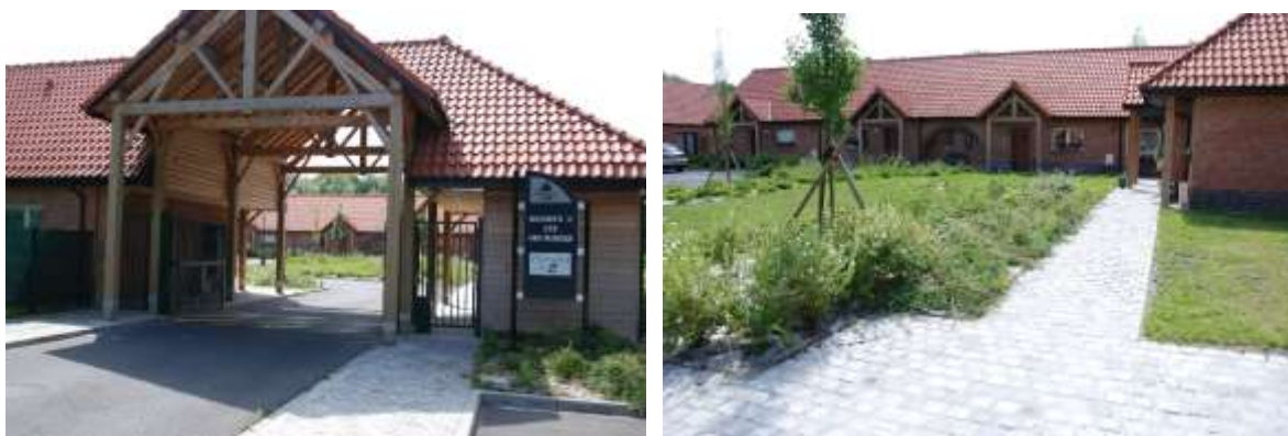
Béguinage de Lauwin-Planque avec son entrée en forme de porche clairement identifiable – Photos L. Nowik
