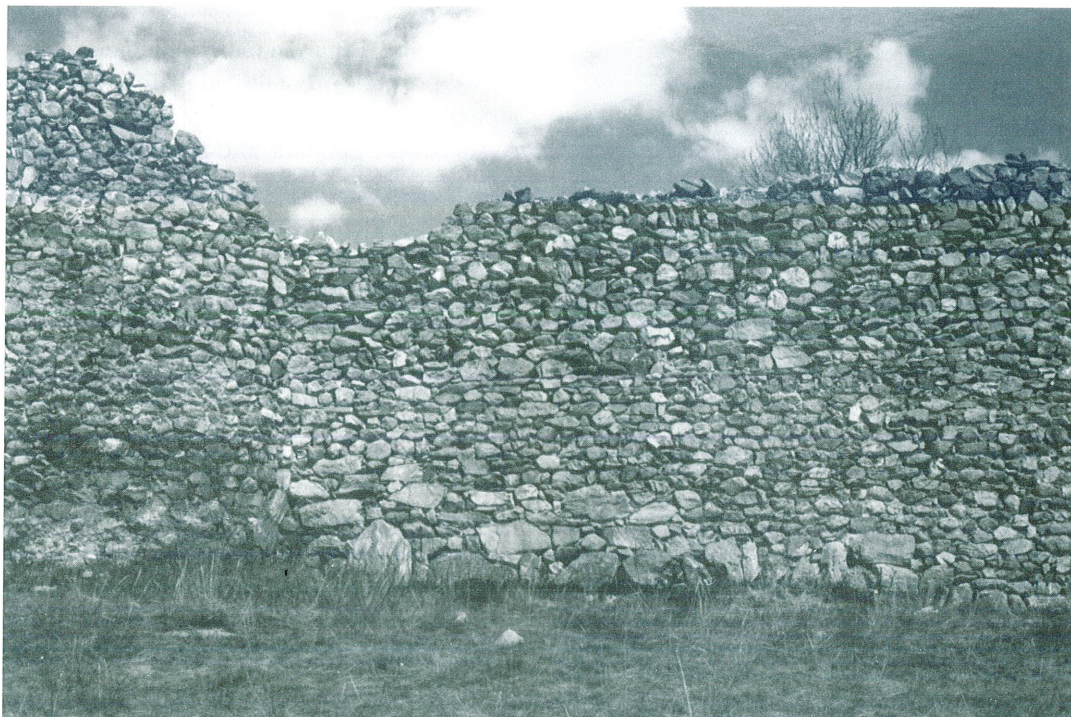
Fig. 13 Photographie du parement du Mur des Vaudois (© N. Nicolas, 1996).
