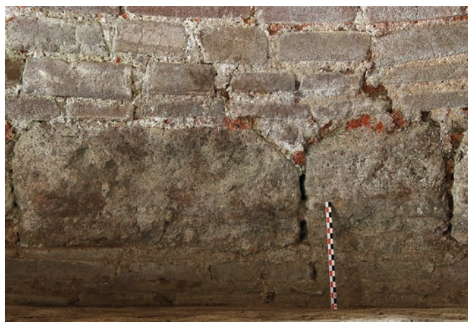
Fig. 21 – Four de la boulangerie VII 2, 3.6.7 : détail de l'anneau de blocs de basalte reposant sur deux assises de tuiles (cliché : N. Monteix, EFR ; © Soprintendenza Speciale per i Beni Archeologici di Napoli e Pompei).
