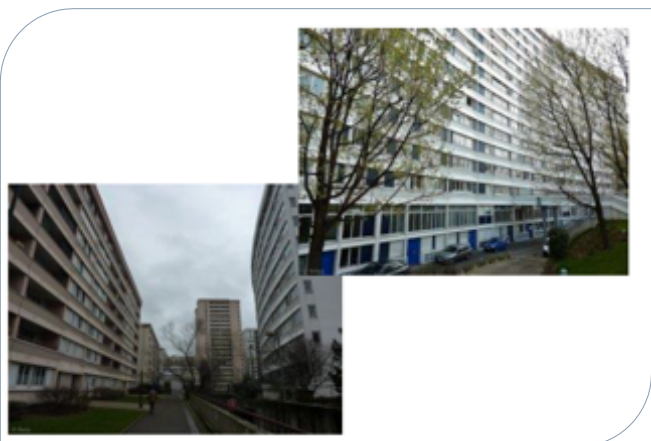
Figure 1: Photos du quartier choisi pour le projet
