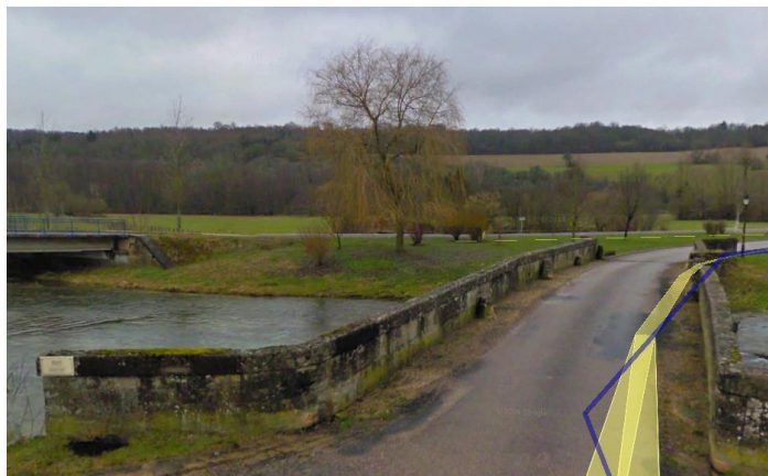
Ancien pont sur la Saulx à l’entrée de Bazincourt 478
