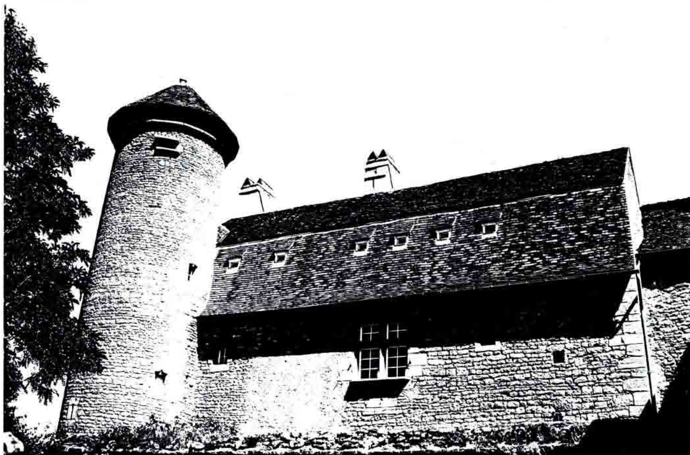
Fig. 7.8 : L'habitation du prieuré de Commagny (cliché 996/1-30).
