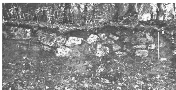
3. Structure de la digue du canal du Tournon (Nièvre).
