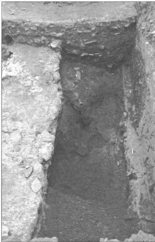
7. La pâture du Couvent. Canalisation de l'état 2 [7369].
