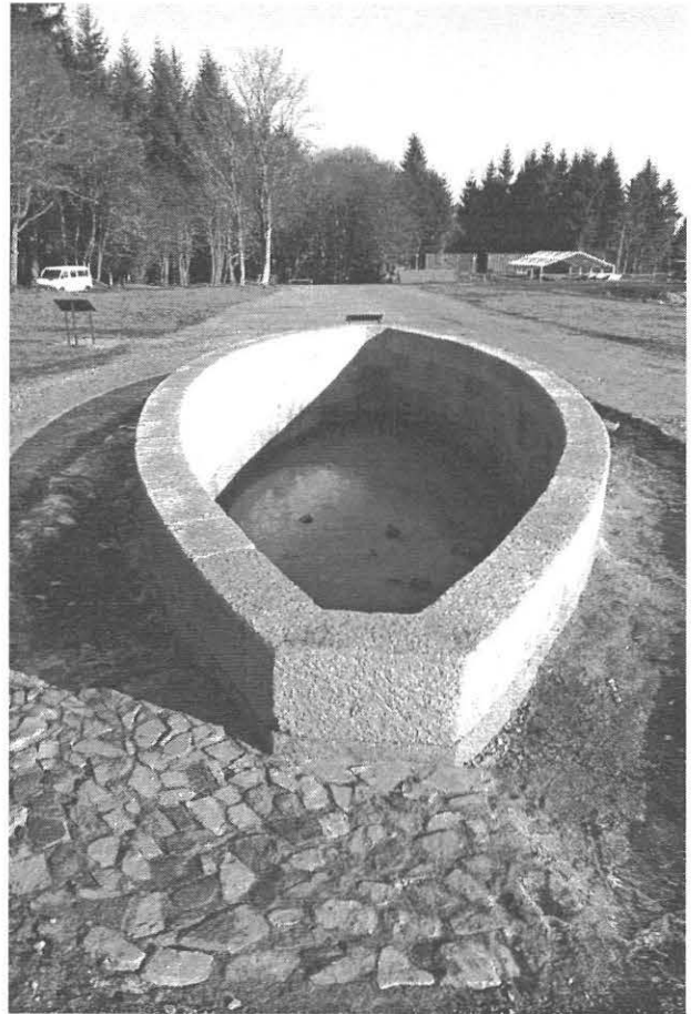
4. Bibacte Mont Beuvray. Le bassin naviforme sur la voie principale à la Pâturage du Couvent, remonté à partir du soubassement antique existant.
