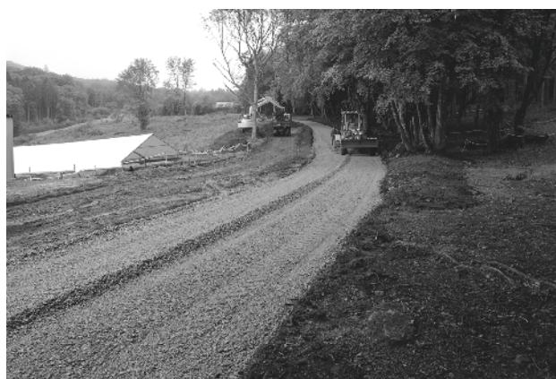
Bibracte, Mont Beuvray. Route à la Côme Chaudron-Champlain après déplacement.
