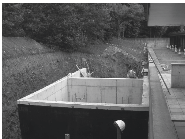
Bibracte, Mont Beuvray. Installation de la chaufferie du musée.
