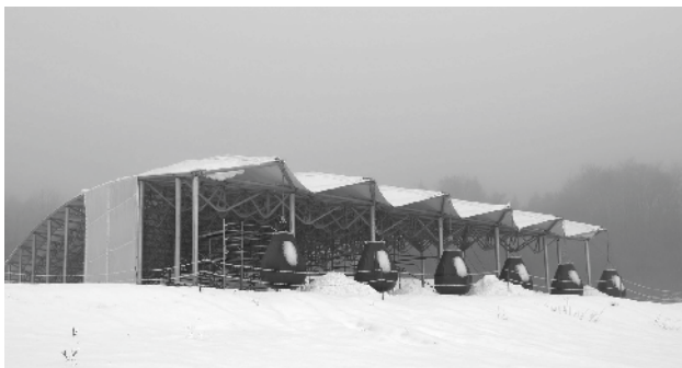
Vues d'ensemble et de détail du nouvel abri installé à la Pâture du Couvent (architecte: Paul Andreu).
