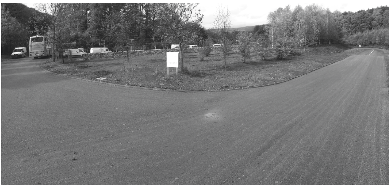
Vues des abords du carrefour d'accès au site, à l'issue des travaux de la campagne 2008.
