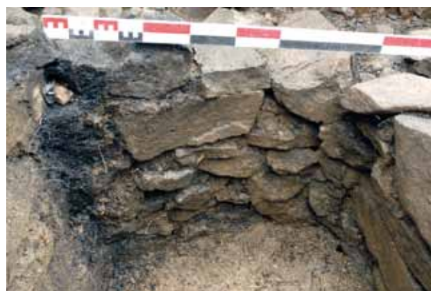
26. Bibracte, Mont Beuvray, Le Theurot de la Roche. Les parements internes du puits [751].
