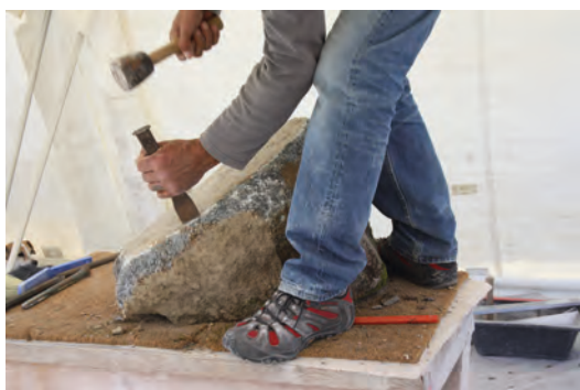
Épannelage du flanc
