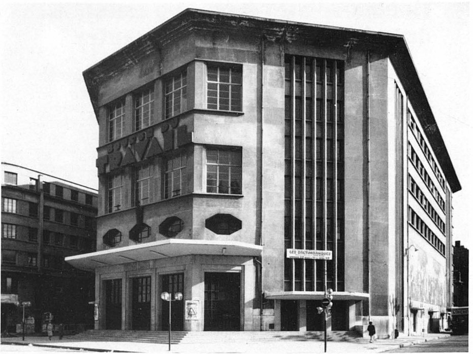
Bourse du Travail : façade principale.
