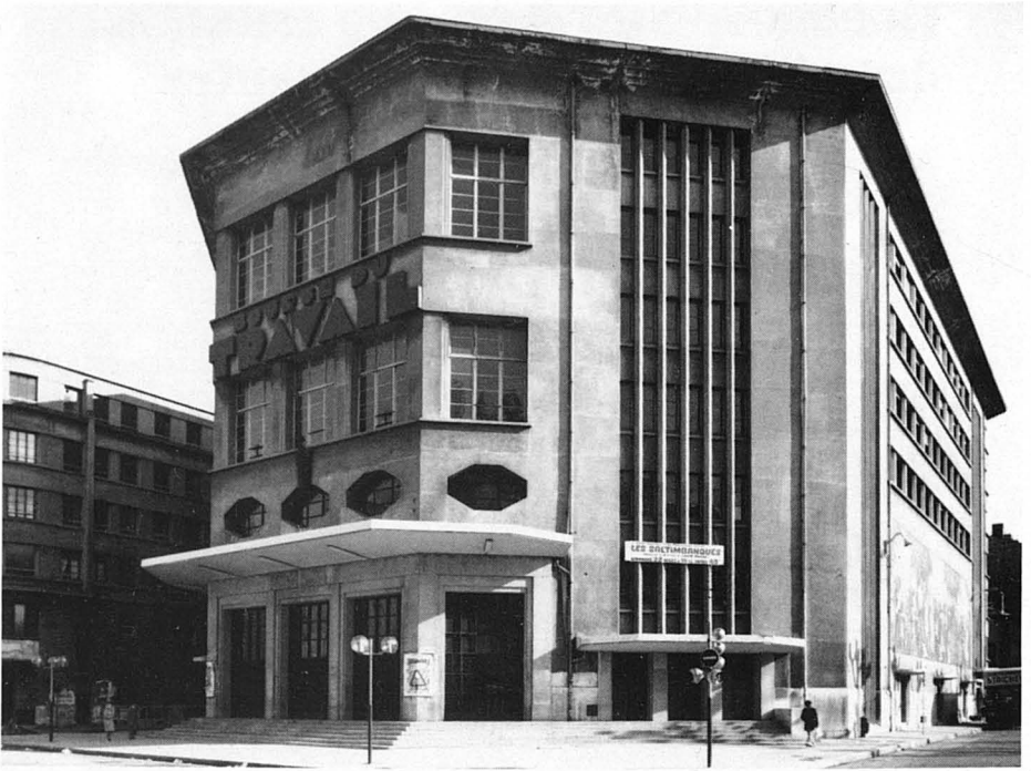
Bourse du Travail : façade principale.
