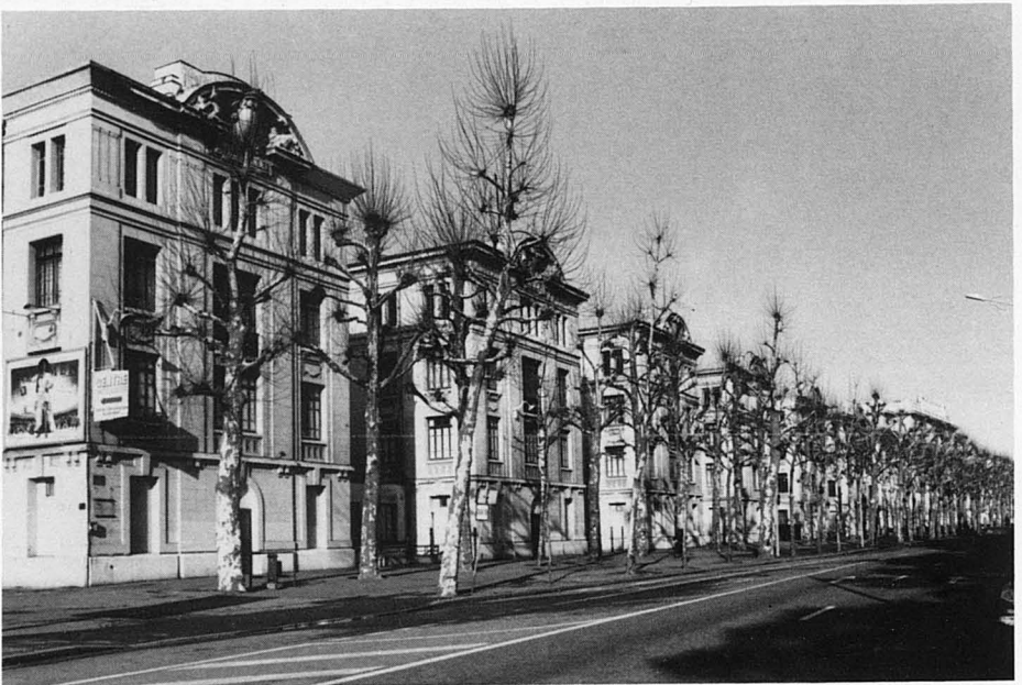
Palais de la Foire : façade sur le parc.
