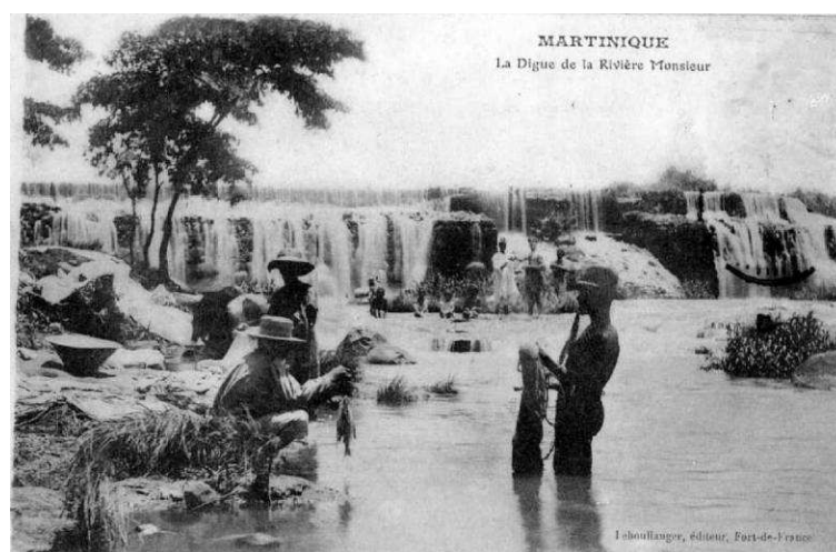
Figure 40 – Pendant qu'une femme s'occupe du linge, deux hommes pêchent du poisson en aval de la digue de la Rivière Monsieur. (Source Banque numérique du patrimoine martiniquais 2Fi2103)
