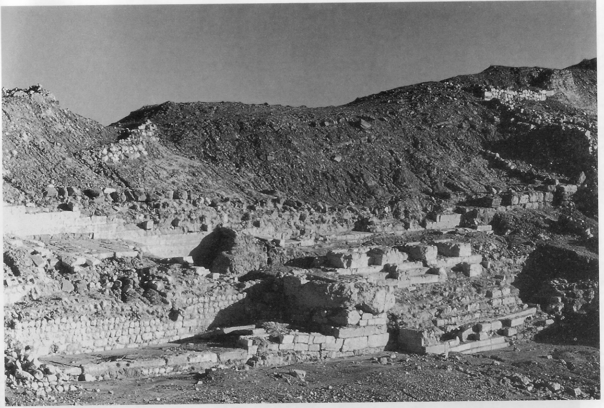
Fig. 4 - Vue vers le sud.
