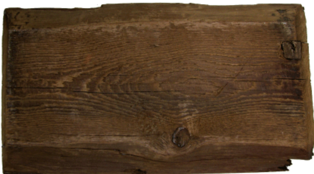
Fig. 27 : Revers brut de sciage du closoir illustré en figure 53 (cliché P. Maritiaux, LA3M).
