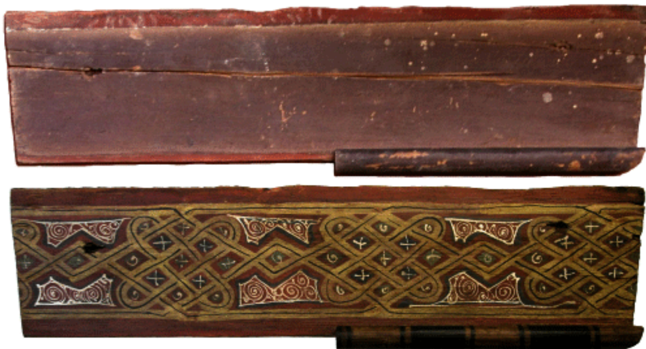
Fig. 60: Planche à motif d'entrelacs servant de console au registre des closoirs et des bandeaux, vue avant et après intervention (clichés P. Maritiaux, LA3M).
