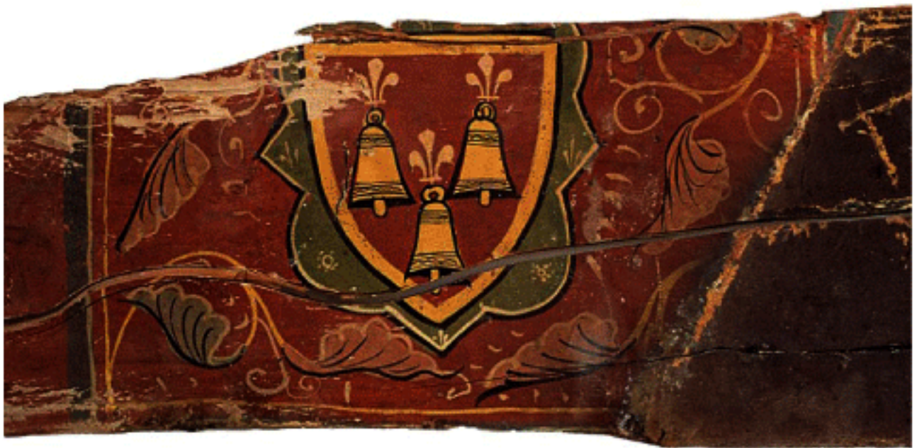
Fig. 5 : Extrémité d'un fragment de bandeau ("d" de la figure 4) prolongeant le registre des clossoirs telle qu'elle se présentait avant intervention. La surface où la polychromie originale est restée exempte de repeint correspond à la partie du bandeau engagée sur la poutraison. La limite oblique du badigeon brun suit l'inclinaison du clossoir venant buter sur le bandeau (cliché J.M Perin, Inventaire général, ADAGP).
