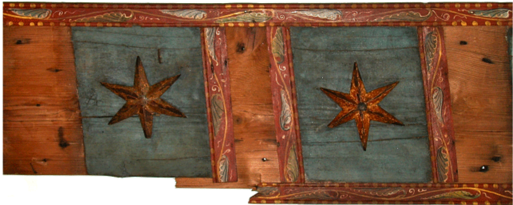
Fig. 64 : La principale lame de plancher après restauration et remise en place de couvre-joints et de baguettes de bordure des compartiments étoilés. Vues générale et détail (clichés P. Maritoux, LA3M).
