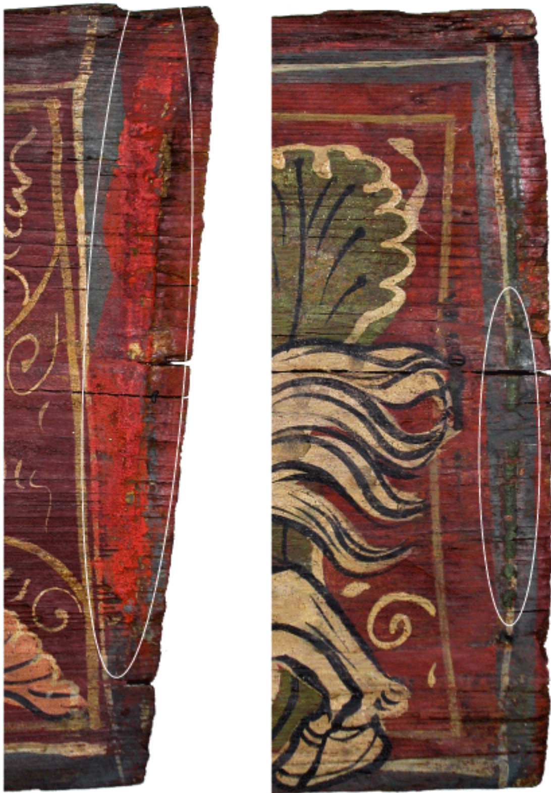
Fig. 25 : Débordements, sur les côtés de deux closoirs, de peinture rouge ou verte provenant de la mise en couleur des solives (clichés P. Maritiaux, LA3M).
