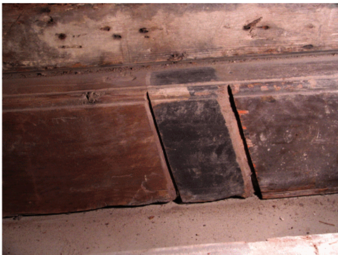
Fig. 24 : Éléments de polychromies, rouge ou noire, visibles entre les rainures d'insertion des closoirs constitutifs des deux états chronologiques du plafond. La solive de la vue supérieure montre aussi au passage de la poutre une couche orangée encore sous-jacente, peut-être une couche au minium (clichés P. Maritiaux, LA3M).
