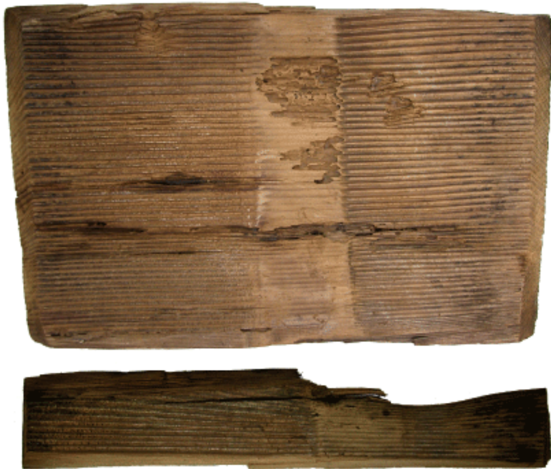
Fig. 26 : Revers du closoir et du fragment de closoir illustrés en figures 54-a et 65-e présentant une surface ravinée par le soleil et les intempéries (cliché P. Maritiaux, LA3M).
