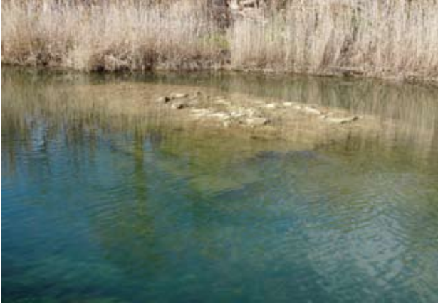
6 : La pile de pont de Villefalse (© Eric Gaillardrat)
