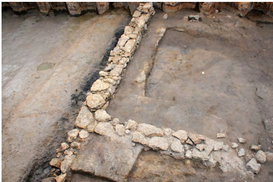
■ Fig. 76 : Vue depuis le sud-est du chaînage entre MR6904 et MR69015
