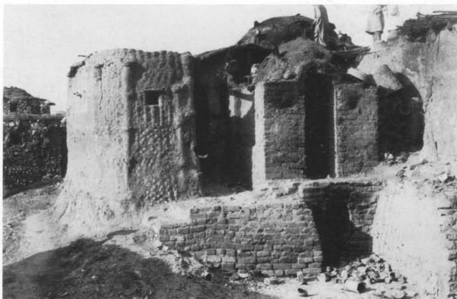
c — four n° 11 et entrepôt attenant.
