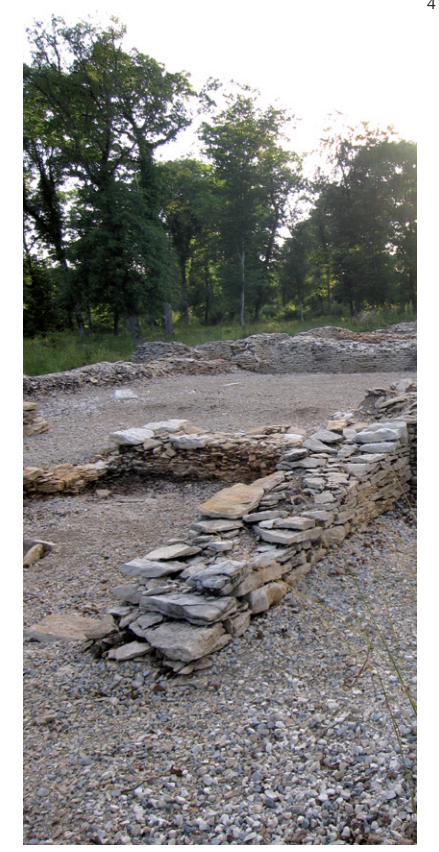
3. Ferme H2 vue depuis le nord. 4. Ferme H2 vue depuis le sud.
