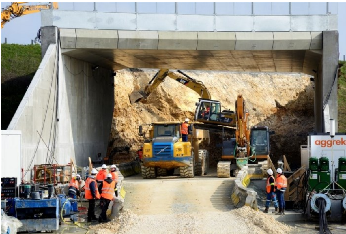
Photo 1 : Tranchée couverte RN147 première opération d'auto fonçage (Source : Alain Montaufier pour LISEA, avril 2013)
