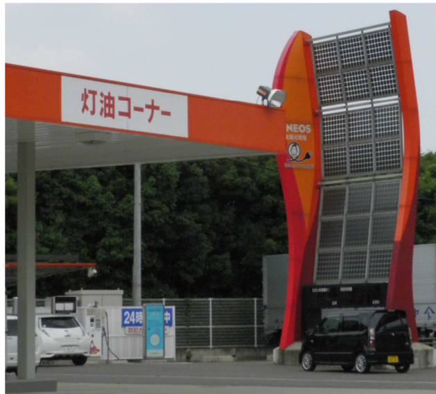
Figure 21 : Station de recharge avec production solaire dans la station-service ENEOS à Higashida
