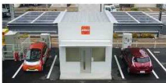
Figure 20 : Station de recharge utilisant le système BCIS
